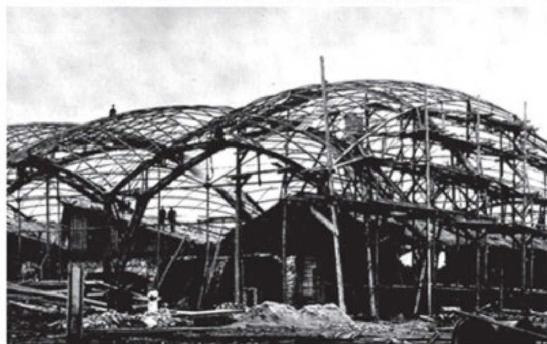
■ Строительство первых в мире сетчатых оболочек-перекрытий двойной кривизны на Выксунском металлургическом заводе, 1897 год
