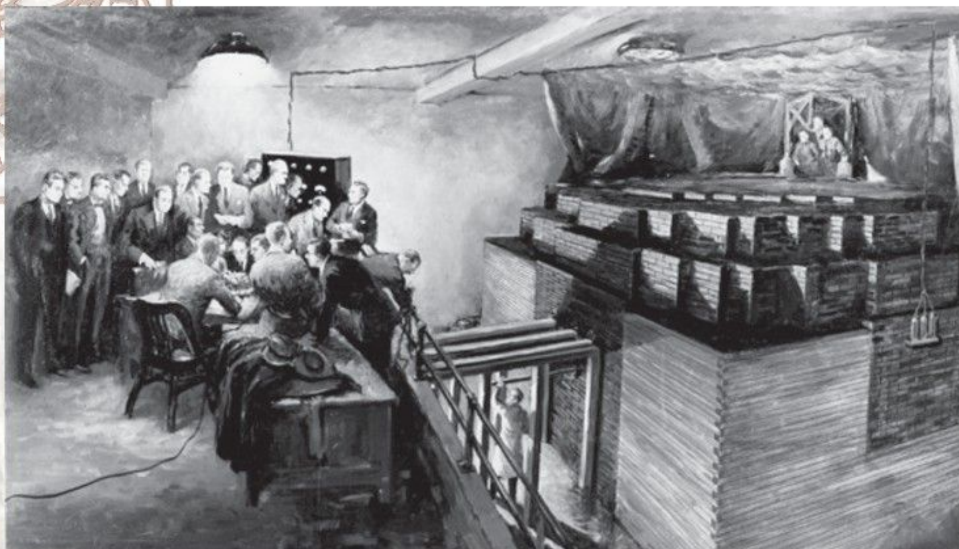
■ Первый, построенный в 1942 году в США исследовательский реактор — «Чикагская поленница» — представлял собой штабель графитовых блоков, между которыми располагались выточенные из урана шары
