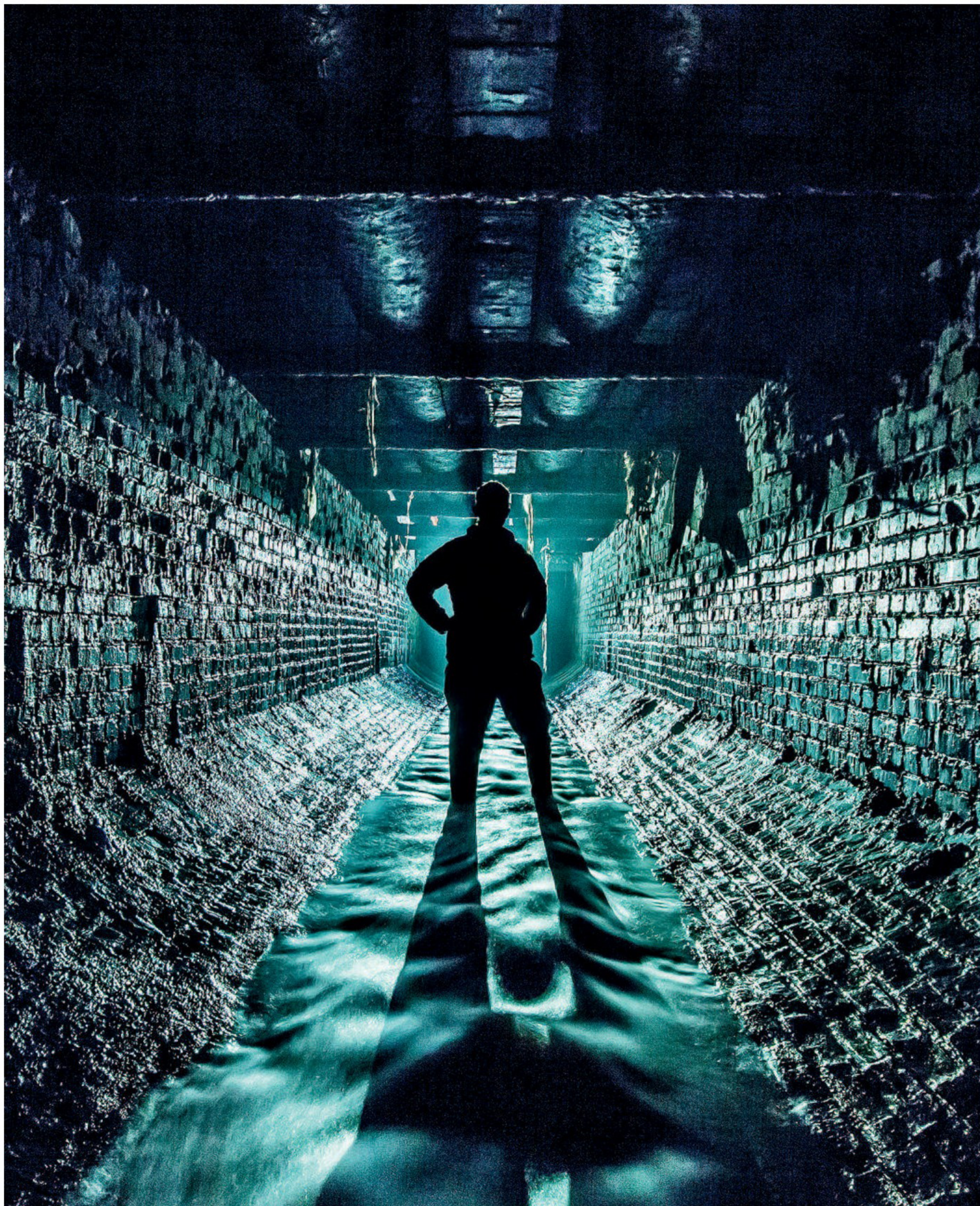
РЕДКИЙ СЛУЧАЙ – КОЛЛЕКТОР РЕКИ ФИЛЬКИ БЫЛ ПОСТРОЕН УЖЕ В СССР (1960-Е ГОДЫ), однако в качестве строительного материала был выбран кирпич, а не обычный для того времени бетон. Еще одна нечасто встречающаяся особенность – под потолком коллектора проложены трубы теплосети.
