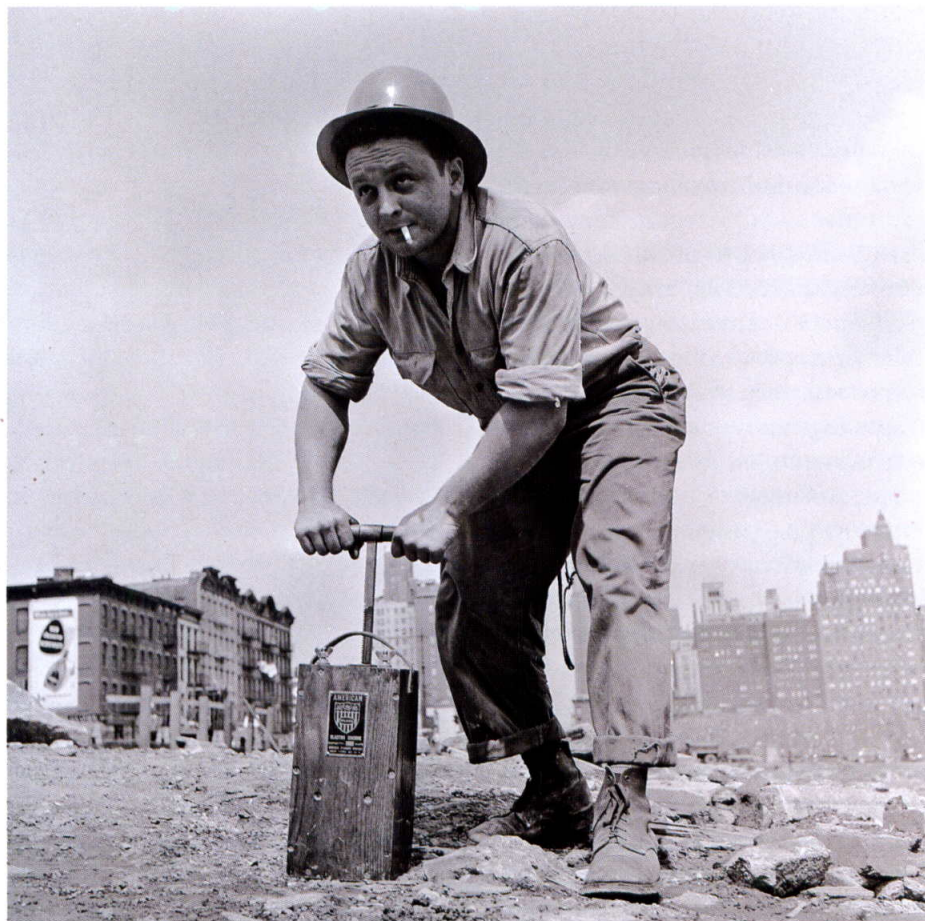
555 | Использование динамита при рытье карьера. Взрывной метод был очень опасен для окружающих, но резко снижал стоимость земляных работ
