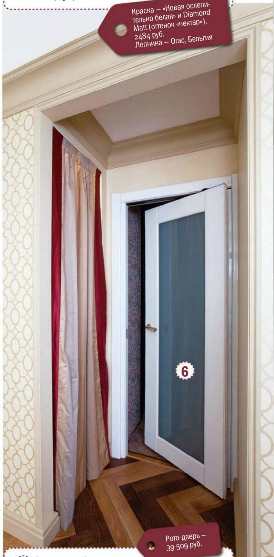
**6** Рото-дверь из белого акрилата с матовой стеклянной вставкой имеет поворотный механизм, который позволяет открывать ее в обе стороны. Очень удобная конструкция для небольшого тамбура, который образовался после того, как была выгорожена гардеробная.
