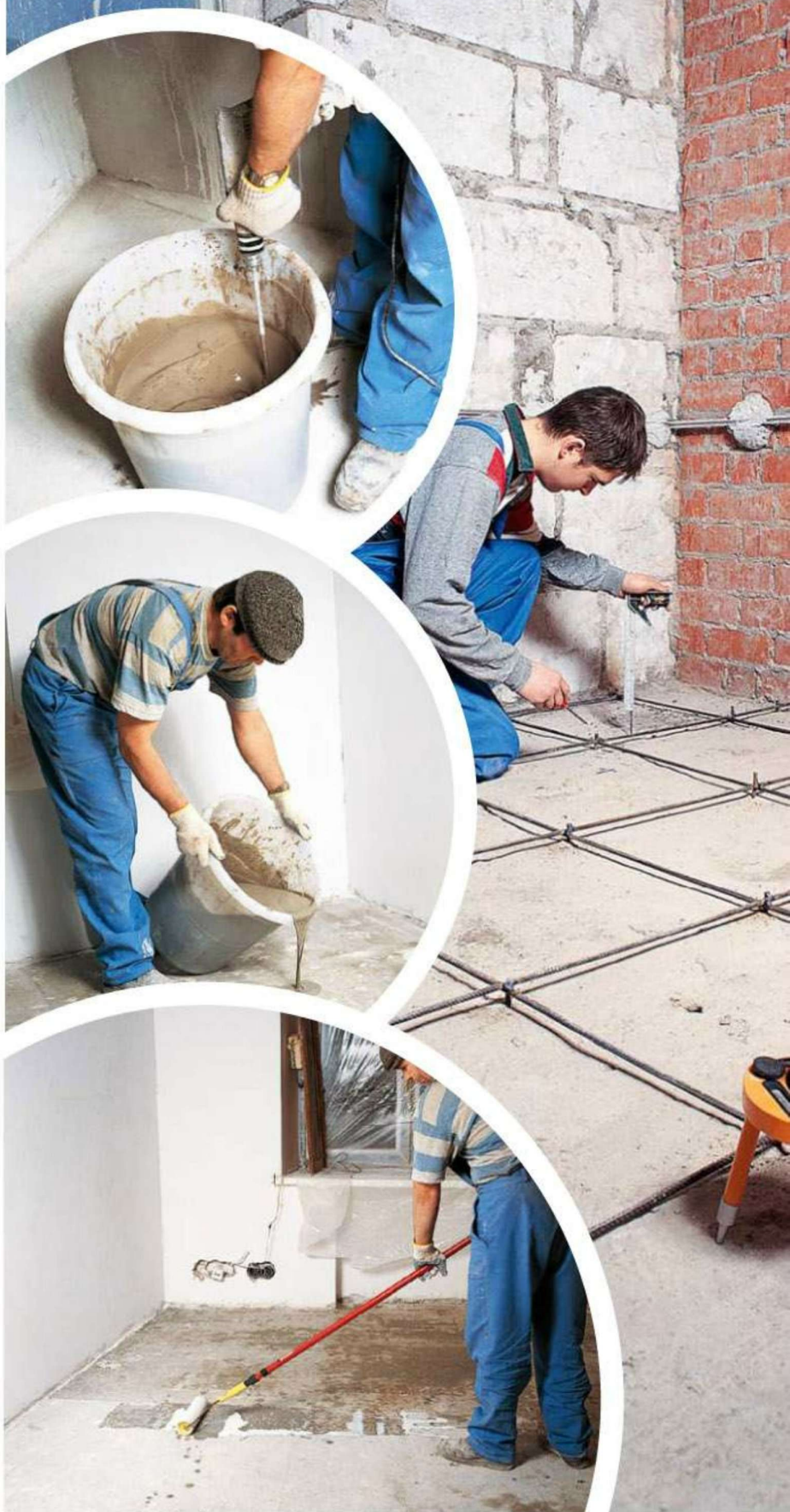
Процесс монтажа самовыравнивающейся напольной стяжки
