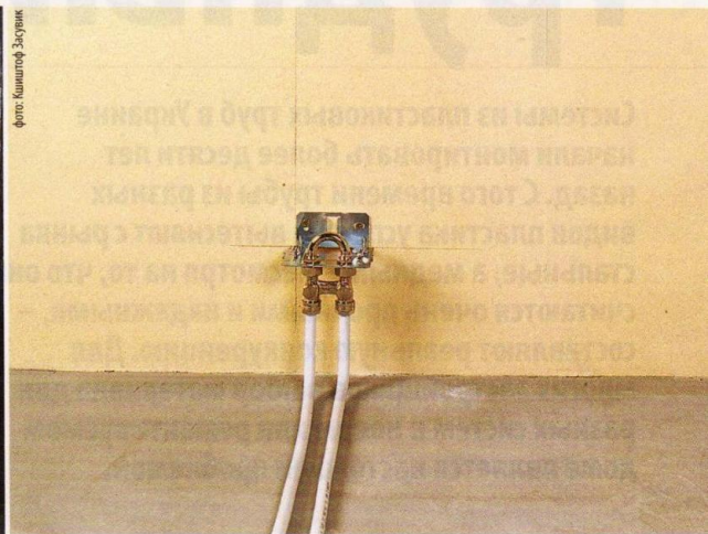
...или кратчайшим путем по полу, в слое стяжки, изгибая их соответствующим образом
