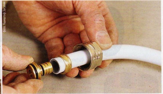
Монтаж систем, в которых соединения выполняются с помощью фитингов разного типа, являются наименее трудоемким
