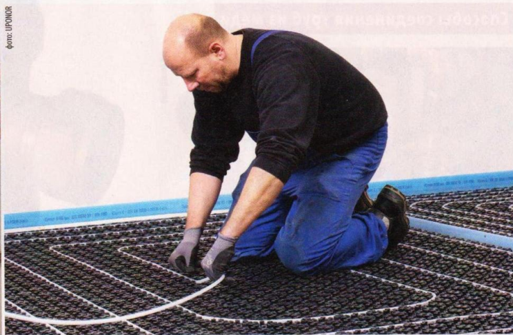
Трубы из сшитого полиэтилена широко используются для систем теплых полов. Они имеют специальный диффузионный слой, предотвращающий проникновение кислорода в систему
