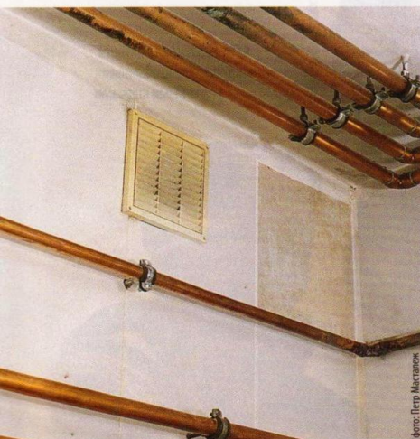
Медные трубы чаще всего используют в системах, которые укладывают поверх стен
