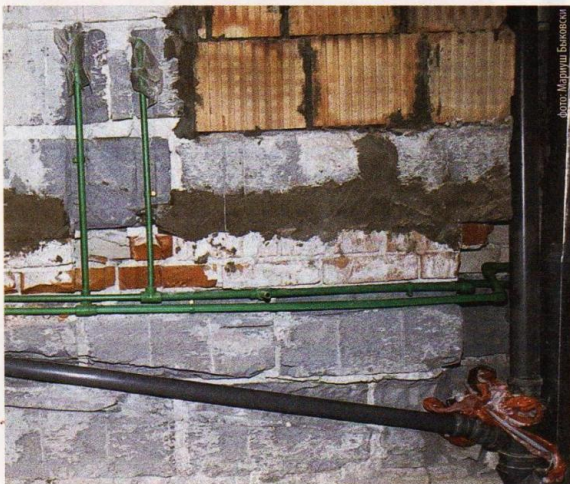
Пластиковые трубы можно вести по стенам, используя фасонные детали, – тройники и колена...
