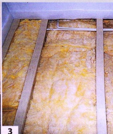
3 Для выполнения дилатационного шва к стенам (по периметру всех помещений) с помощью скобок прикреплены два слоя ленты из вспененного полиэтилена шириной 10 см и толщиной 0,5 см. Так был получен достаточный дилатационный шов между стенами и жесткими элементами «плавающего» пола
