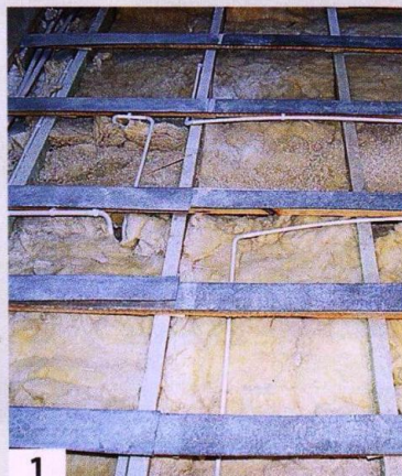
1 Работы начали с демонтажа покрытия пола и подкладочного слоя из древесно-стружечных плит. Благодаря этому открылись балки перекрытия. Это дало возможность убедиться, как небрежно была уложена минеральная вата, являющаяся теплоизоляцией перекрытия
