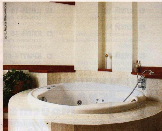
↑ Полоса из плиток завершена декоративными полочками в нишах, которые создают выразительную границу между поверхностью, облицованной плиткой, и окрашенной стеной
