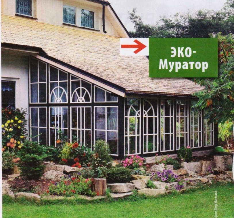
↑ Застекленное буферное пространство с южной стороны дома является эффективным солнечным коллектором
