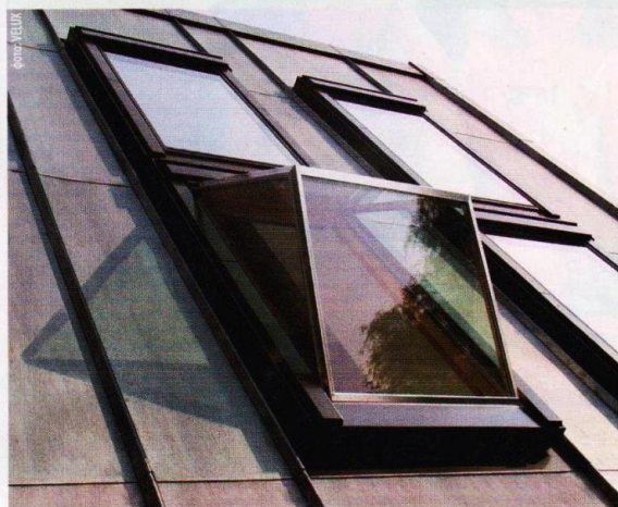
↑ Существуют мансардные окна, напоминающие традиционную люкарну. Сквозь прозрачные боковые стенки в мансарду проникает больше света
