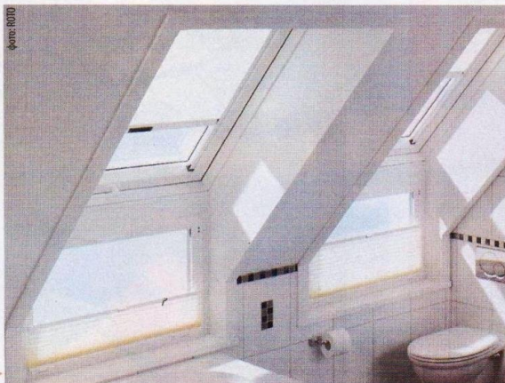
↑ Мансардные окна из ПВХ доступны только в форме прямоугольника, но их можно блокировать или соединять с карнизными окнами, которые увеличивают инсоляцию помещения
