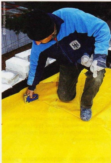
↑ Уложенную на плиты OSB пароизоляционную пленку крепят скобами. Сверху укладывают теплоизоляционный материал
