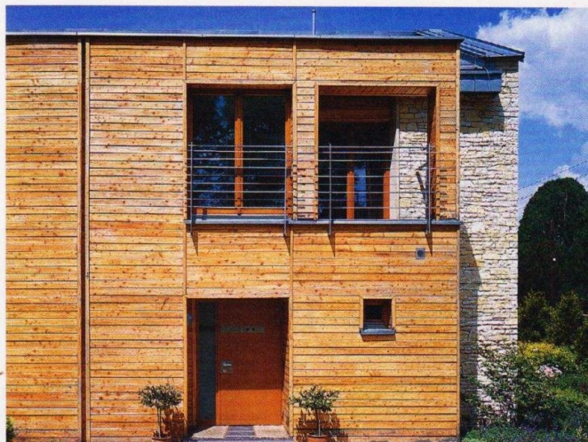
↑ На стенах из бетона и газобетона уложены доски разной длины. Они крепятся к деревянному каркасу, а места соединения скрыты вертикальными планками
