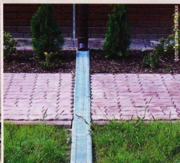
↑ Решетки в системе линейного водоотвода могут быть стальными, пластиковыми и чугунными
