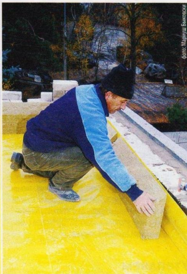
↑ Во время работ по термомодернизации нужно утеплить не только саму площадь совмещенной крыши, но и все вертикальные элементы, особенно парапетные стены
