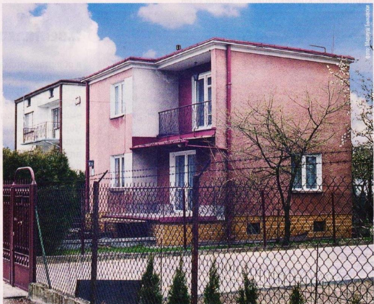
↑ Если средства уже вложены в ремонт фасада, и в данный момент его утепление не планируется, сохранить тепло необходимо, хотя бы термообновив крышу
