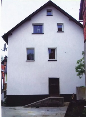
После установки вентфасада
