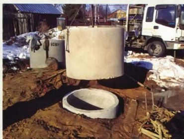
3 Рабочий залазит в кольцо и, используя ведро на веревке, подает вверх землю и воду. Постепенно кольцо погружается
