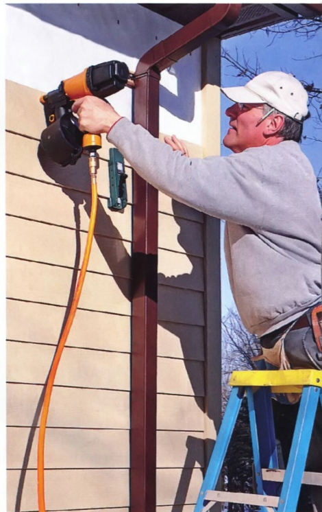
Небольшой вес декоративных плит значительно ускоряет монтаж системы
