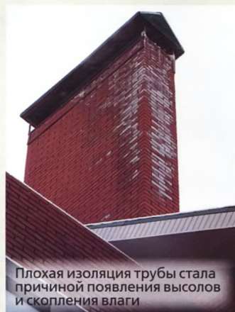
В трубе были объединены каналы дымохода и вытяжной вентиляции кухни, что привело к образованию наледи
