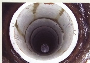
4 Сверху ставят новые кольца. Внутренние и наружные стыки защищают цементным раствором
