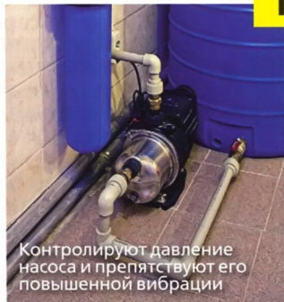
Перед заливкой новой воды в систему отопления проверяют работу фильтров
