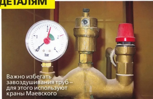
Контролируют давление насоса и препятствуют его повышенной вибрации
