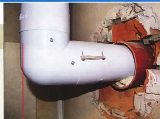
Пластиковые дымоходы максимально просты в сборке и прокладке
