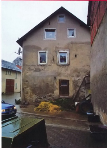
До установки вентфасада
