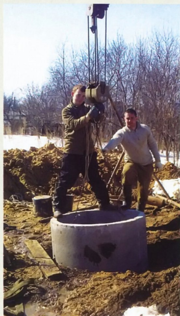
3 Рабочий залазит в кольцо и, используя ведро на веревке, подает вверх землю и воду. Постепенно кольцо погружается
