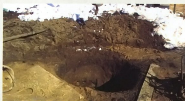
1 Копают шахту с небольшим запасом под диаметр и высоту кольца
