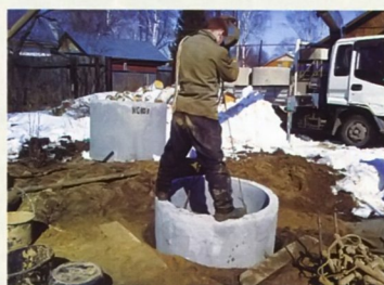
2 Опускают первое кольцо. Важно выставить его строго по уровню!
