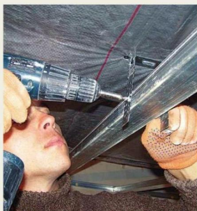
5 С помощью П-образного подвеса закрепляют направляющий профиль на нужном уровне
