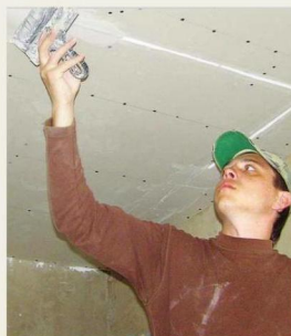
9 Поверх армирующей ленты наносят еще один слой шпатлевки
