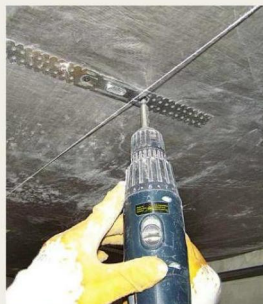
3 Несогнутый П-образный профиль крепят к базовому потолку
