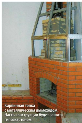
Металлические топка и дымоход, обложенные кирпичом
