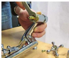
5 Для выкручивания сердцевины используют ключ для многогранников
