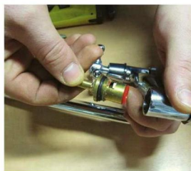
6 Вынимают сердцевину с керамической прокладкой и заменяют ее новой
