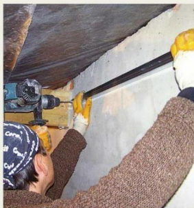
2 Стеновой профиль крепят пластиковыми дюбелями
