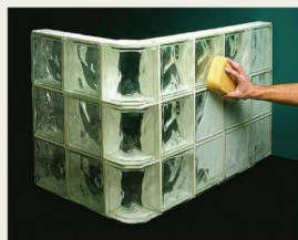
6 Готовую конструкцию аккуратно вытирают, освобождая от кусков застывшего раствора
