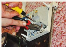
4 Подключают систему к нагрузке и прикручивают УЗО
