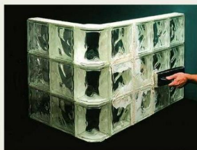
5 Все швы обрабатывают специальной затиркой под цвет блока
