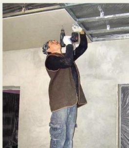
7 ГКЛ крепят к каркасу потолка специальными шурупами
