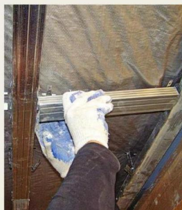
6 Создание каркаса потолка завершают креплением несущего профиля
