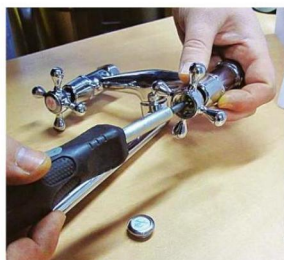
2 Отверткой, чаще крестовой, выкручивают фиксирующий винт
