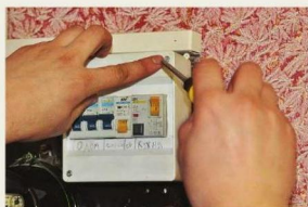
5 Надевают пластмассовую панель
