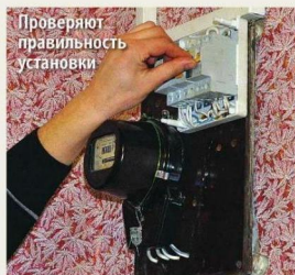
3 Устанавливают УЗО на рейку, зажимают защелку для надежного соединения
