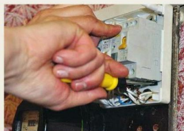
3 Устанавливают УЗО на рейку, зажимают защелку для надежного соединения
