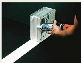
2 Для стыковки вертикальных стенок используют специальные разделительные планки
