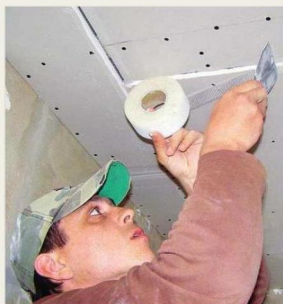
8 Щели между ГКЛ шпательюют и закрывают самоклеящейся лентой
