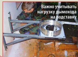
Место прохождения дымохода сквозь стену нужно заизолировать
