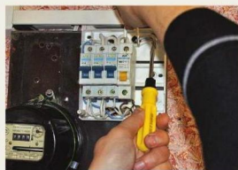
1 Подключают перемычку-проводник – фазу от соседнего автомата
