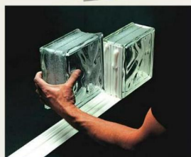
3 Время схватывания определяется типом клея и составляет от нескольких часов до нескольких дней
