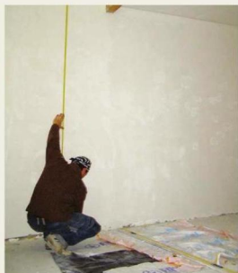
1 Установка нулевого уровня – важный этап создания потолка
