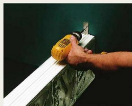
4 Перед укладкой следующего ряда монтируют новую горизонтальную направляющую, фиксируя ее на стене
