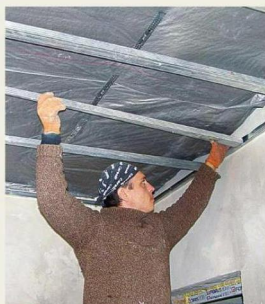
4 Создавая каркас, направляющий профиль вставляют в стеновой
