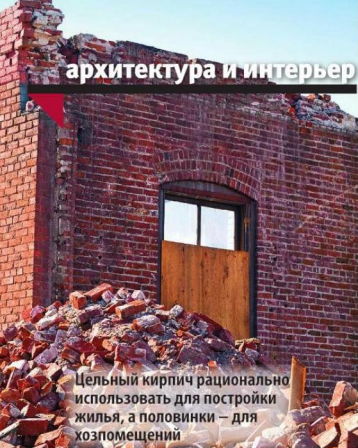
Если кирпич местами выкрошился, а раствор при этом сохранился, материал не удастся извлечь невредимым
