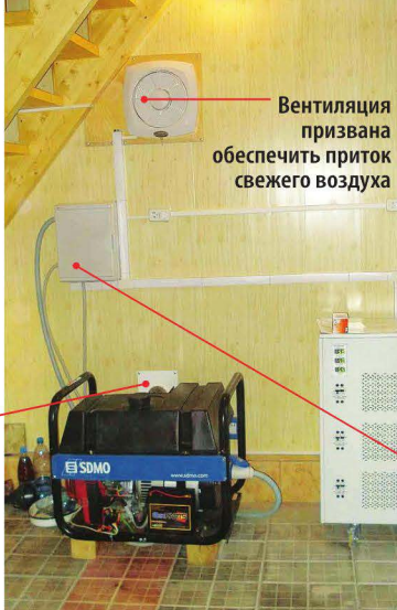
Приборы, которые нужно питать от генератора, выводят на отдельный контур, размещаемый в том же щитке энергоснабжения дома
