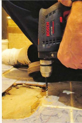
4 Накерняют отметки. Просверливают плитку, переключают дрель в режим перфорации и доделывают отверстие
