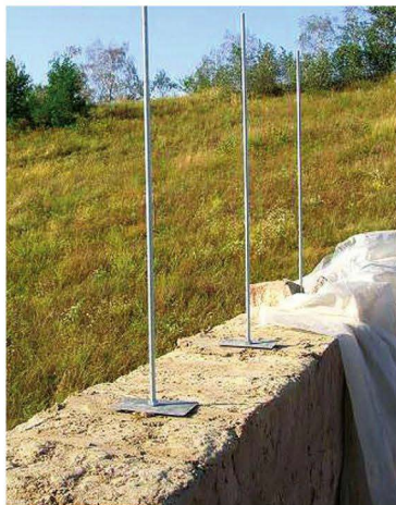
7 Металлические шпильки для крепления мауэрлата вмуровывают в стену на 3-4 ряда
