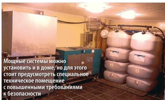
Приборы, которые нужно питать от генератора, выводят на отдельный контур, размещаемый в том же щитке энергоснабжения дома
