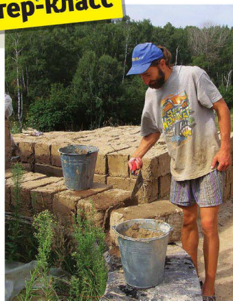
3 В качестве раствора используют тот же саман, только более жидкий
