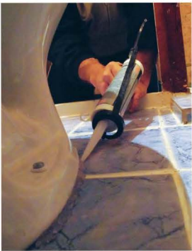
8 Дополнительно фиксируют чашу и заделывают щели силиконовым герметиком. Посредством гибкого шланга подводят воду к бачку
