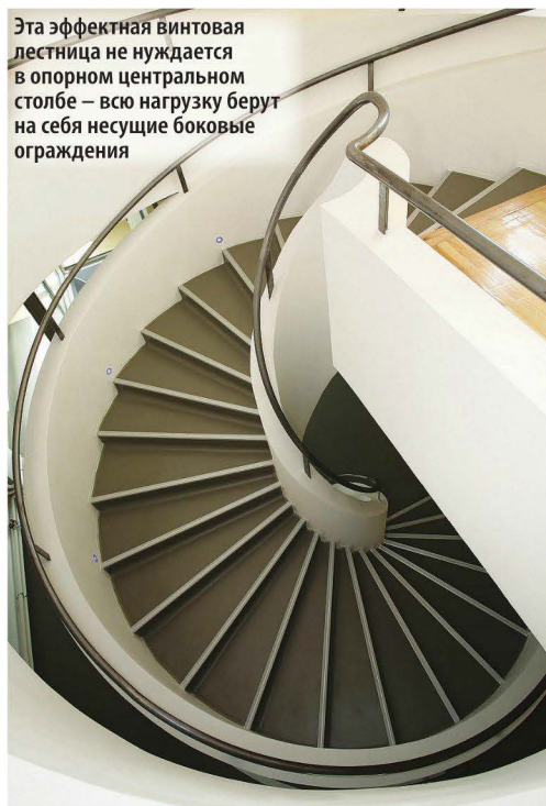
Несущий элемент конструкции – мощная центральная стойка, на которой закреплены ступени
