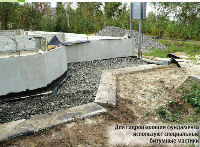
В некоторых случаях необходимо устройство цоколя, особенно тогда, когда в стенах комбинируют несколько разных материалов
