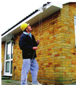
1 Фиксируют воронку, используя отвес
