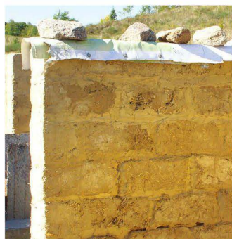
4 Если работа останавливается на несколько дней, верхнюю часть стены нужно закрыть от дождя
