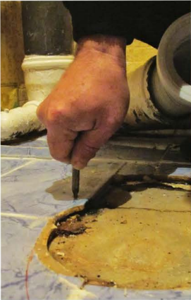
4 Накерняют отметки. Просверливают плитку, переключают дрель в режим перфорации и доделывают отверстие
