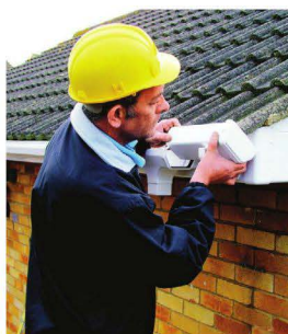
7 Установив все элементы желоба, фиксируют заглушки
