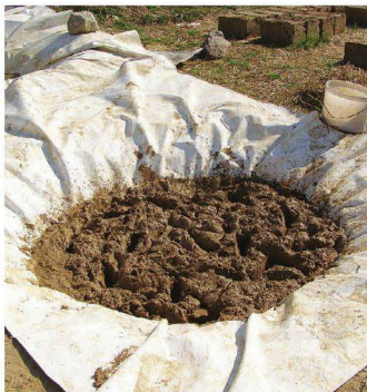
1 Замешивают саман ногами на водонепроницаемой ткани
