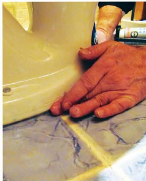
8 Дополнительно фиксируют чашу и заделывают щели силиконовым герметиком. Посредством гибкого шланга подводят воду к бачку
