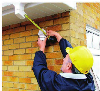
8 Фиксируют колено трубы в воронке и определяют размер трубы для соединения
