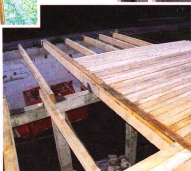
Настил выполняют из деревянных щитов разной ширины с высотой около 5 см
