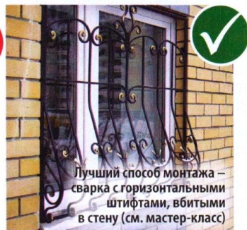
Накладные решетки относительно просто вырвать, если не вручную, то автомобилем
