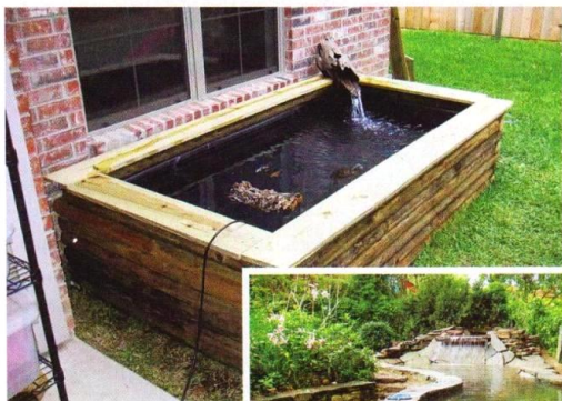
Основу больших чаш выполняют из бетона или пленки
