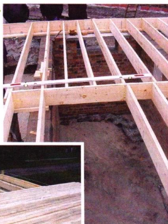
Настил выполняют из деревянных щитов разной ширины с высотой около 5 см
