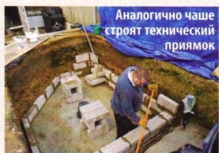
Заливают бетон и разравнивают его
