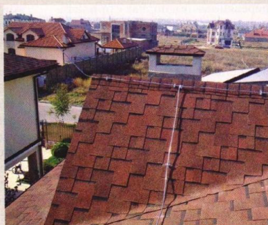
2 По крыше разводят молниеприемную сетку, которую крепят к кровле
