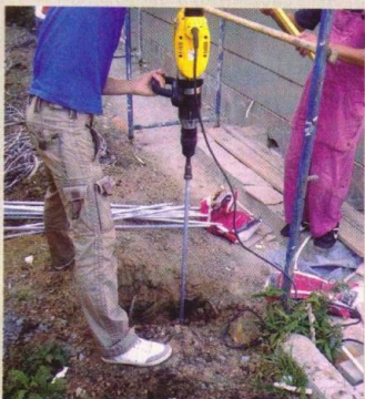
4 Бурят скважину и опускают в нее заземлитель
