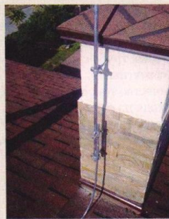
1 Устанавливают приемник, который выше самой высокой точки здания
