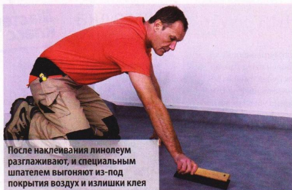
Если необходимо уложить покрытие на плитку, убедитесь, что клей обеспечит надежное сцепление с таким гладким невпитывающим основанием
