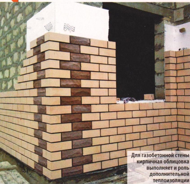
Вариант устройства единой кладки без разделительного слоя
