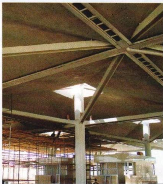
Подшивка свесов сооружений цементной плитой AQUAPANEL®
