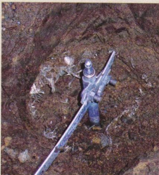
5 Соединяют молниезащитный стержень и заземлитель, создавая цельный контур
