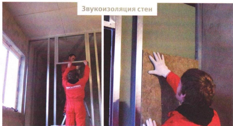
Звукоизоляционный материал может служить наполнителем в межкомнатной гипсокартонной перегородке
