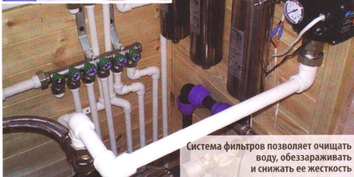
Чем меньше в трубопроводе изгибов, тем лучше напор и качество воды
