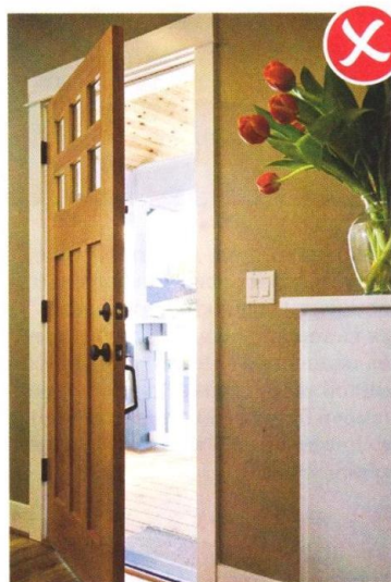
Дверь открывается внутрь дома, что неудобно в маленьком тамбуре. Стеклянные вставки являются мостиками холода
