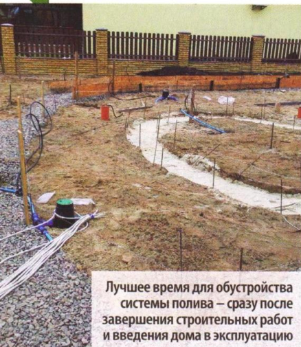
Работы по обустройству скрытого полива вряд ли можно провести безболезненно, если газон уже сформирован. Придется существенно вмешиваться в покрытие, но со временем коммуникации будут видны минимально
