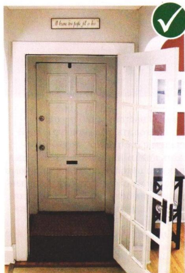
Внешняя дверь выполнена из массива дерева. Внутренняя остеклена для естественного освещения тамбура
