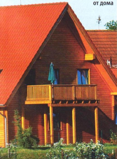
Конструкция балкона полностью независима от дома
