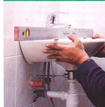
Устанавливаем раковину в санузле
