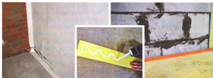
Готовые стены звукоизолируют специальными плитами, которые устанавливают на виброизолирующую подложку
