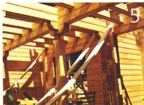
Не стоит экономить на устройстве перекрытий и пола – это приведет к потере жесткости конструкции и низкой шумоизоляции между этажами
