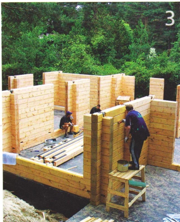
◀ Дерево покрывают одним слоем грунта и двумя слоями лессирующего колорируемого септика, который не образует пленок, позволяя дереву дышать
