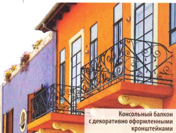
Консольная конструкция шириной до 120 см не требует дополнительных опор
