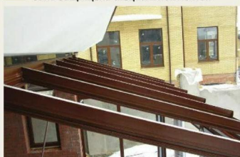
2 До окончания работ конструкция должна быть защищена специальной лентой
