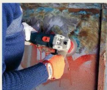
2 При необходимости шлифуют металл болгаркой с кругом-щетинной
