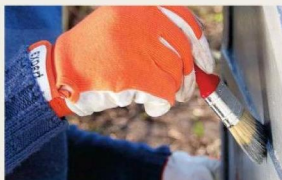
7 Кисточкой докрашивают участки, на которые краска не попала
