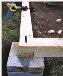
2 Столбчатый каменный фундамент надежней, особенно когда арматура соединяет кирпич с горизонтальными и вертикальными планками
