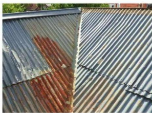
Разные типы покрытий выходят из строя по-разному: кровля может ржаветь, деформироваться, трескаться и т. п.
