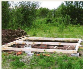
2 Столбчатый каменный фундамент надежней, особенно когда арматура соединяет кирпич с горизонтальными и вертикальными планками
