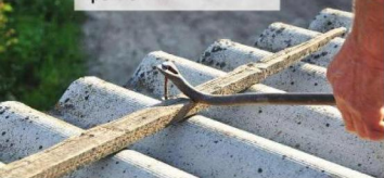
Правильный демонтаж крепления
