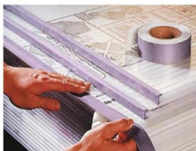
Торцы сотового поликарбоната нужно обязательно закрывать, чтобы избежать попадания в пустоты грязи и насекомых
