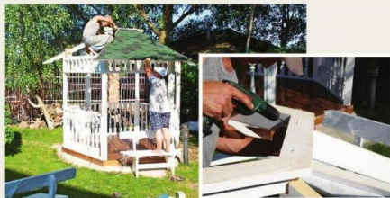
6 Готовую беседку покрывают кровлей, чаще легкой – битумной или металлической. В завершение расставляют мебель
