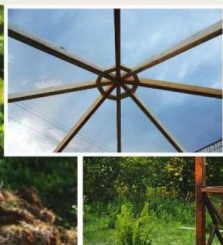
3 Все работы проводят от основания к крыше. Для соединений используют арматуру, гвозди, шурупы. Защищают дерево пропиткой
