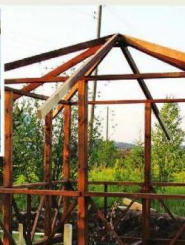
3 Все работы проводят от основания к крыше. Для соединений используют арматуру, гвозди, шурупы. Защищают дерево пропиткой
