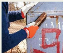
1 Удаляют старую краску посредством щетки со стальной щетиной
