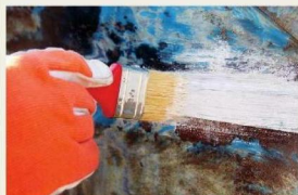
5 После преобразователя применяют грунтовку
