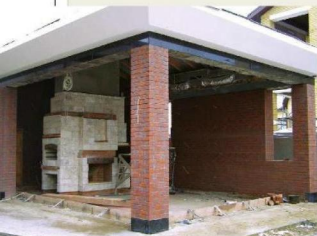
1 Зимний сад требует надежного фундамента
