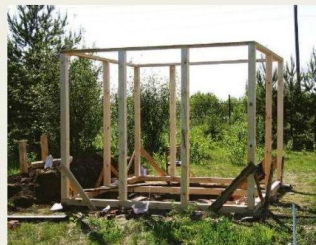
3 Все работы проводят от основания к крыше. Для соединений используют арматуру, гвозди, шурупы. Защищают дерево пропиткой
