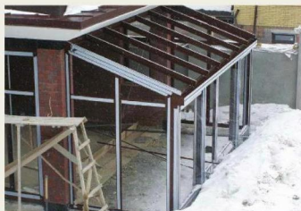
2 До окончания работ конструкция должна быть защищена специальной лентой
