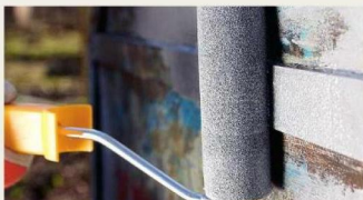
6 Средством поролонового валика наносят первый слой краски
