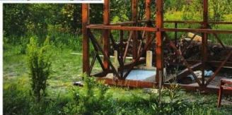
4 Собрал основной каркас, выполняют перила и покрывают стропила
