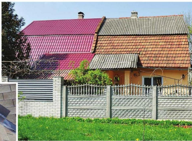
▲ Пример визуально неудачной и функционально неэффективной комбинации покрытий – на одной крыше натуральная черепица никак не сочетается с другими видами кровли и тем более с шифером
