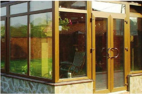
Конструкция из ПВХ – самое экономичное решение. Пластик может быть цветным, а также покрытым пленкой «под дерево»
