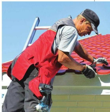
Затем переходят к наружному обследованию крыши, для чего используют лестницу и страховку
