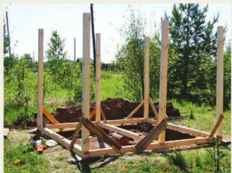
3 Все работы проводят от основания к крыше. Для соединений используют арматуру, гвозди, шурупы. Защищают дерево пропиткой
