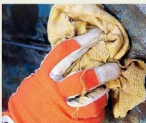
3 Тряпкой удаляют пыль и осевшие частицы содранной краски
