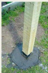
1 Место под беседку выравнивают. Для фундамента используют столбы с арматурой или защищенные мастикой деревянные стойки
