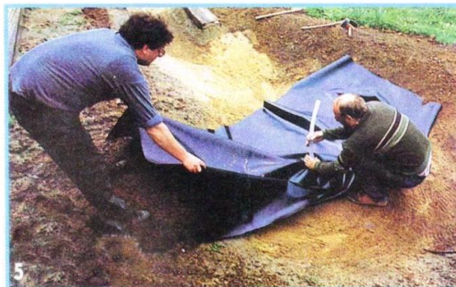
Трубу для перекачки воды протаскивают через плёнку. Чтобы в этом месте не образовалась течь, края отверстия уплотняют специальным клеем (так называемой жидкой плёнкой).
