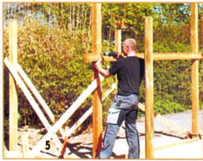
Установленные стойки дополнительно фиксируют горизонтальными связями.
