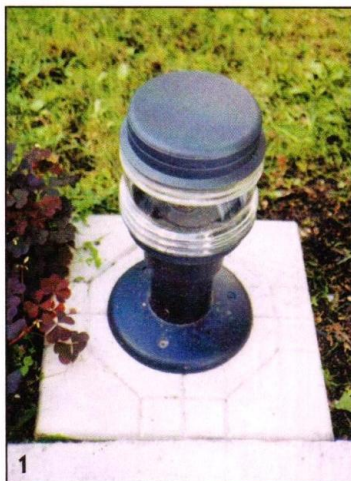
Установка светильника на тротуарной плитке.
