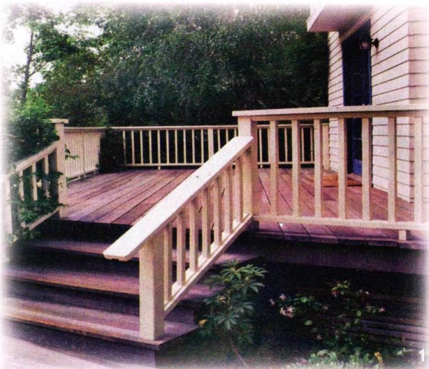
Простое ограждение прекрасно гармонирует со строгой отделкой фасада дома. Нижние перемычки ограждения уложены на деревянные нагели, заделанные в опорные стойки. Решётчатые секции из строганных брусков, заранее собранные на планках, привинчивают к нижним перемычкам шурупами и скрепляют поручнем, уложенным по верхним граням опорных стоек.
