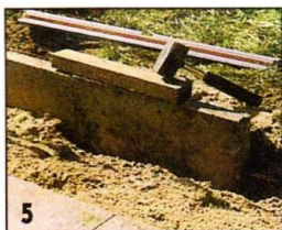
5 Поставленные на ребро и вкопанные плиты будут препятствовать оседанию крайних плит фундамента, особенно если терраса расположена на склоне.
