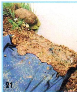
21 На переходе к естественному пруду плёнку укладывают в глинистый грунт, у плёночного пруда-источка плёнку сваривают.
