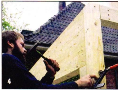
Конструкция приобретает устойчивость лишь после соединения передних стоек поперечным элементом. При креплении соединительный поперечный элемент опирают на отрезок бруска, прижатого к стойке струбциной.
