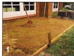
После разбивки участка под террасу вынимают грунт на глубину ~30 см. В котлован отсыпают песок.
