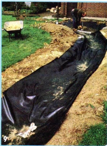
Уклон ручья — не везде одинаковый. Чтобы плёнку уложить правильно, в некоторых местах на неё кладут груз.
