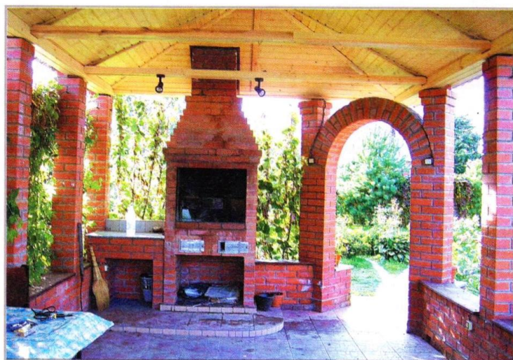
Пол в беседке выложен плиткой с небольшим уклоном. Мангал и разделочный стол стоят на возвышении высотой 100 мм.
