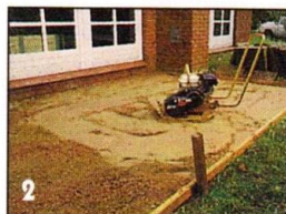
Песчаную подушку тщательно трамбуют. Если площадь террасы — большая, целесообразно использовать угловую вибраторную машинку («болгарку»).
