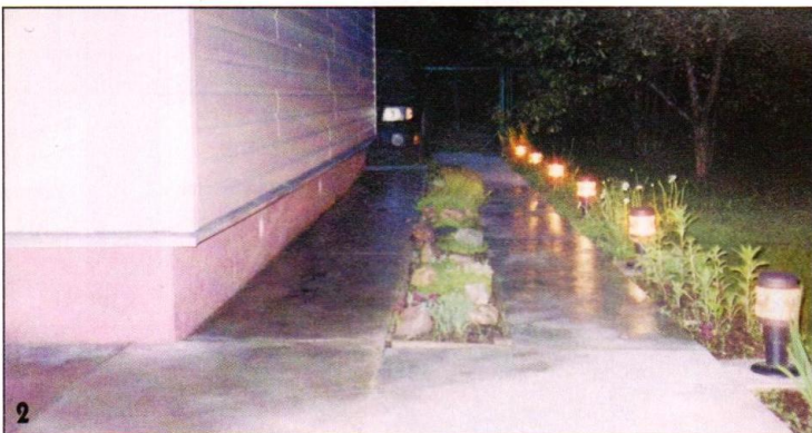
Вдоль дорожек светильники ставят на расстоянии 2,5–3 м друг от друга.
