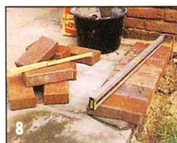
8 После пробной укладки кирпичи кладут окончательно на раствор и тщательно выверяют по высоте.
