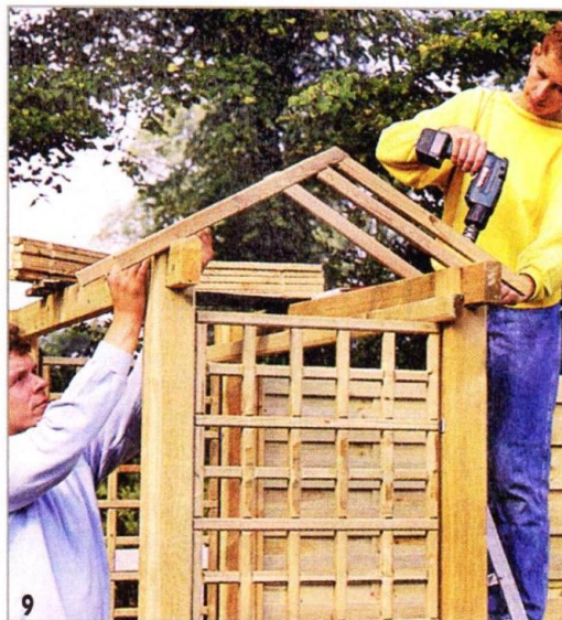
9 Установив стропильный элемент вырезами на балки, его привинчивают к балкам, предварительно просверлив в стропилах отверстия под шурупы.
