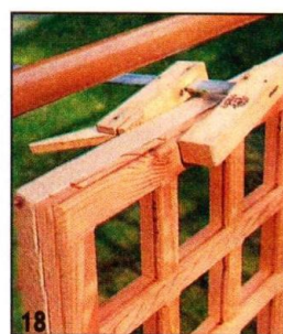
18 Струбины помогут точно подогнать детали рамы к решётке.
