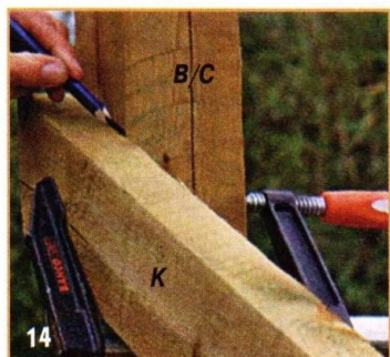
Временно закрепив стропила К струбцинами на стойках В и С, размечают соответствующие выборки.
