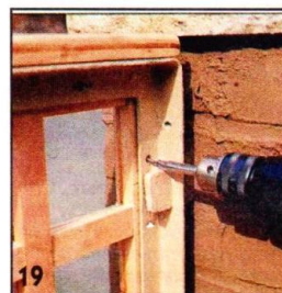
19 В рамах из металлических уголков через каждые 40 см сверлят отверстия \varnothing 4,5 мм под шурупы для крепления решёток.
