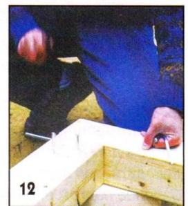
Чтобы усилить соединения, сквозь отверстия стоек и вставок в древесину забивают металлические стержни или заворачивают шурупы-«глухари».
