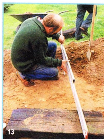
Для выверки опор моста требуется уровень.
