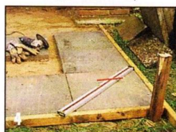
Углы устроенного из бетонных плит фундамента срезают, используя угловую шлифовальную машинку («болгарку»).
