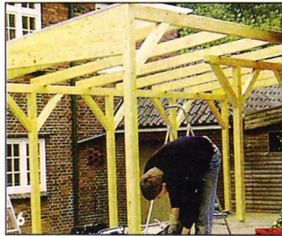
Установив несущий каркас, к стойкам и прогонам крепят подкосы.
