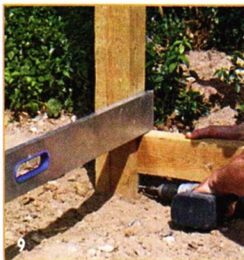
Выверенные по уровню брусья D1 обвязки крепят (уголками вниз) к стойкам А и В.
