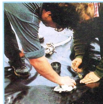
Одно из важнейших вспомогательных средств при устройстве ручья — жидкая плёнка, надёжно уплотняющая стыки.
