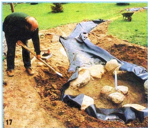
17 Под бассейн-источник вырыли достаточно большой котлован. Теперь, когда форма бассейна определена, его снова заполняют грунтом.
