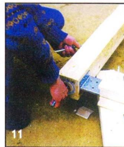
Стропила можно соединить с прогоном посредством металлических П-образных элементов, вставляемых в пазы.
