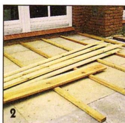
Расстояние между лагами — 60 см. Их кладут свободно, не прикрепляя к плитам.
