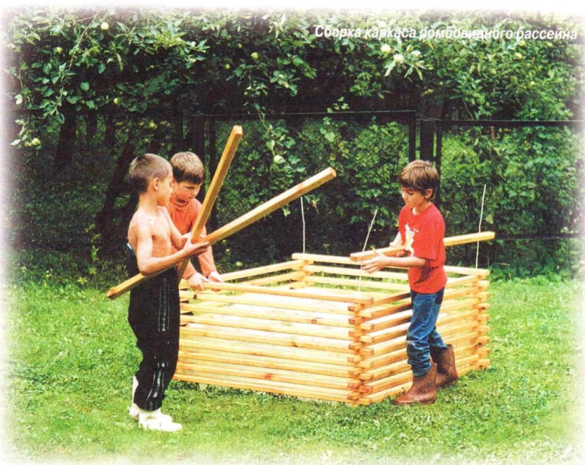
Сборка каркаса ромбовидного бассейна.
