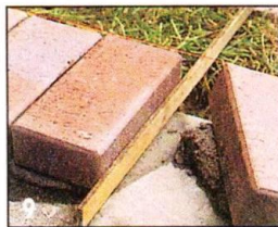
9 Промежутки между кирпичами очищают от раствора до бетонных плит основания. Здесь будет стекать дождевая вода.
