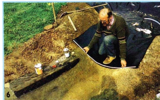
Соединение между бассейном-источником и ручьём. Сначала измеряют ширину следующей полосы плёнки, затем по этой ширине её раскраивают.
