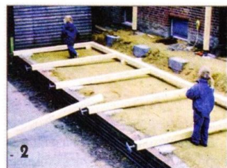
Перед монтажом готовые детали навеса – стойки, прогоны и стропила следует пронумеровать и разложить на площадке. Монтировать можно готовые под сборки.
