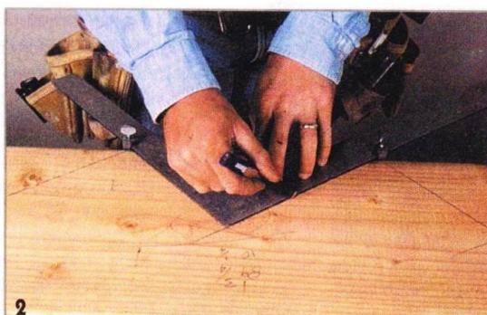
2 Маленькие зажимы, прикреплённые к треугольнику, позволяют разметить все ступени одинаковым образом.
