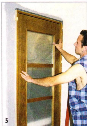
Контрольная проверка дверным полотном как калибром выявила все огрехи в установке коробки. Эту операцию лучше выполнять вдвоём, чтобы вести осмотр со всех сторон.
