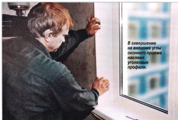
14 Монтажной пеной заполнил пространство между панелью и откосом, предварительно прихватив панель шурупами.
