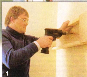
К стенам слева и справа на дюбелях и шурупах крепят детали (рейки и ДСП), имитирующие балки.
