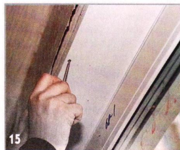
15 Сразу же затянул шурупы окончательно.
