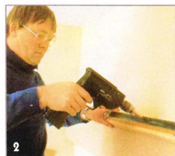
Брусок со скошенной кромкой служит опорой для алюминиевого П-образного профиля шириной 30 мм. Скос выполнен с учётом угла наклона будущего промежуточного потолка.
