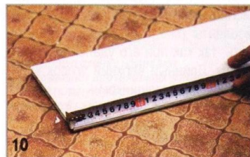
10 Отрезал от заготовки откос в нужный размер. Причём торец панели с этой стороны запилил таким же образом, как и противоположный.
