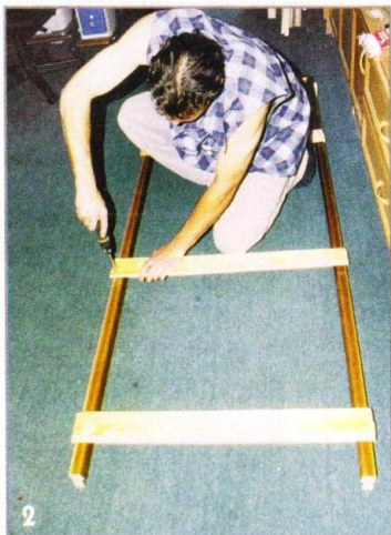
Распорки крепили к боковым брускам саморезами, вворачивая последние поближе к наружным краям. Следы от саморезов потом закроют наличники.
