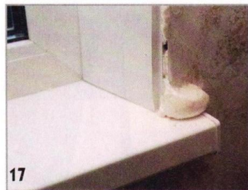
17 Выступившую монтажную пену затем срезал.
