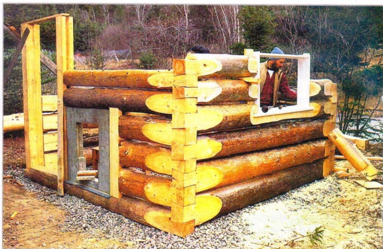
Строитель проверяет посадку оконной рамы, связанной с пазами брёвен шпонкой. Печь встанет в бетонную раму, защищающую брёвна от жара.
