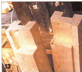
«Правильные» стойки. Благодаря скосам в пазух стоек верхний брусок надёжно удерживается в них.
