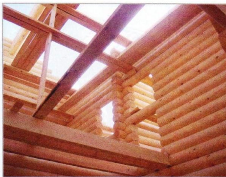
Строительство дома из оцилиндрованного бревна
