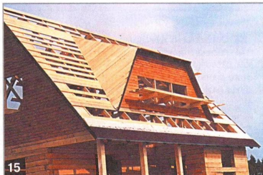
Кровельные работы. Битумная черепица укладывается по сплошному основанию из фанеры, прибитому к обрешётке. Хорошо видны элементы ендовы, уложенные на стыках плоскости крыши со слуховым окном.
