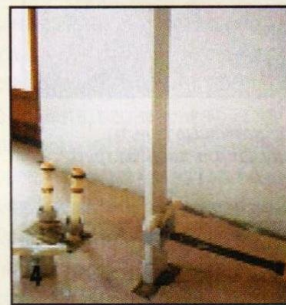
4 Нижние опоры с зажимными кулачками крепят на требуемом расстоянии от пола.
