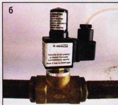
Фото 5. Самый надёжный способ защиты от утечки газа — это установка прибора определения загазованности (а) и управляемого им электромагнитного клапана (б), перекрывающего магистраль.
