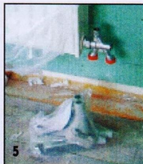
5 К втулке крепят вентиль для подающего и обратного трубопроводов. Его положение необходимо выставить по вертикали.
