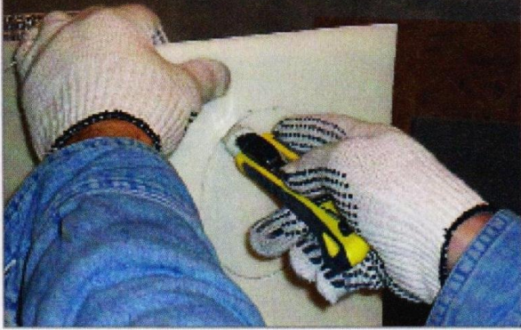
Проделать отверстие во вспененном полиэтилене для установки врезки достаточно просто.
