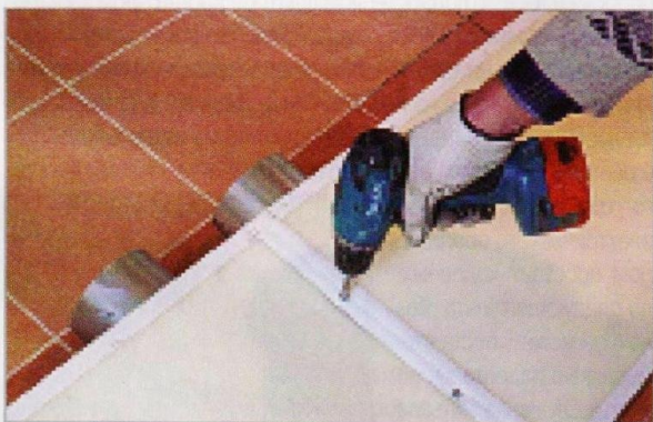
Усиление стыка частей магистрального воздуховода саморезами.
