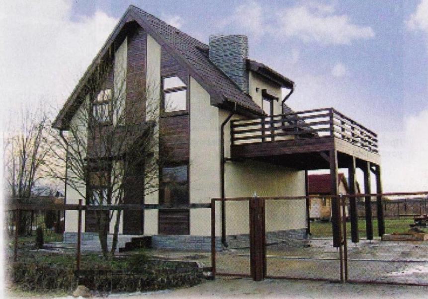
Дом в Подмоскowie, в котором производился монтаж СВО.
