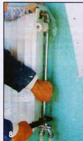
8 К установленному сверху вентилю термостата монтируют трубу, к которой присоединяют узел для подключения трубопроводов.
