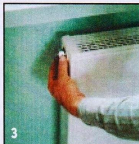
3 В верхнюю часть батареи ввёртывают вентиль для выпуска воздуха, внизу ставят заглушку.
