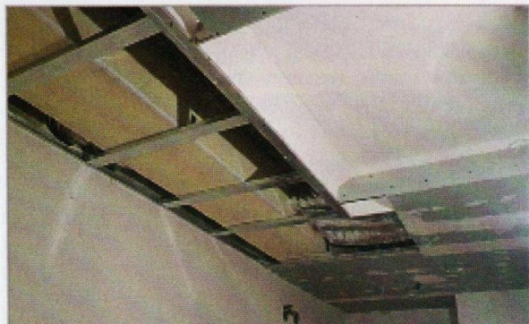
Смонтированный магистральный воздуховод.
