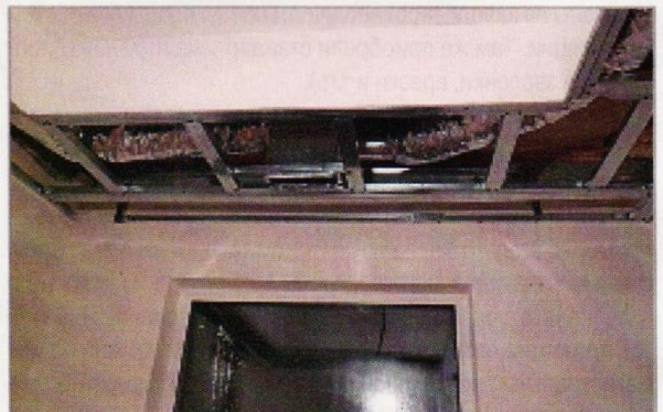
Монтаж гибких воздуховодов в подготовленный каркас двухуровневого потолка.
