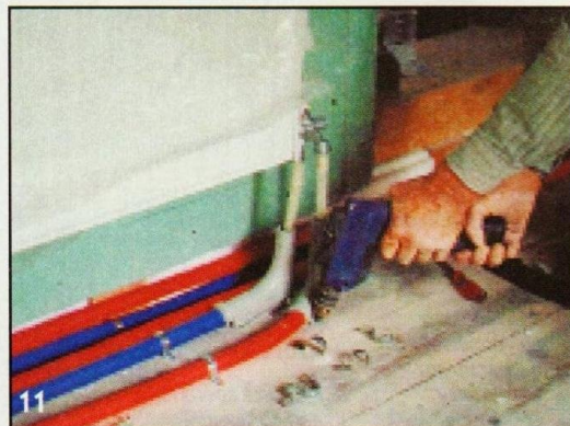
Закреплённые таким образом колена устанавливают на соответствующие выходы вентиля, подсовывают под них трубы и привинчивают к полу трубные башмаки.
