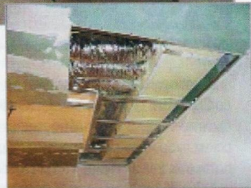
Смонтированный магистральный воздуховод.
