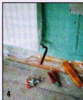
4 Пользуясь ключом, с другой стороны батареи внизу ввинчивают втулку с внутренним шестигранником.
