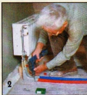
2 После подготовки элементов подключения труб можно настилать новое покрытие пола.
