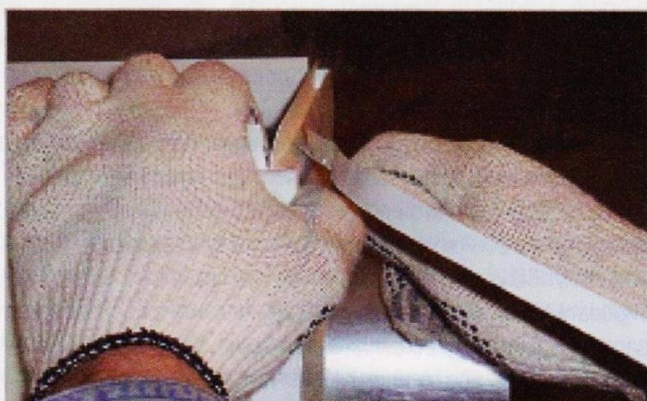
Крепление Н-профиля для стыковки частей магистрального воздуховода.
