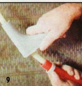
На оболочку трубопровода надевают стопорное кольцо, внутреннюю трубу вводят в защитный башмак.
