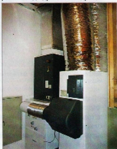
Установленный воздухогреватель «АНТАРЕС Комфорт».
