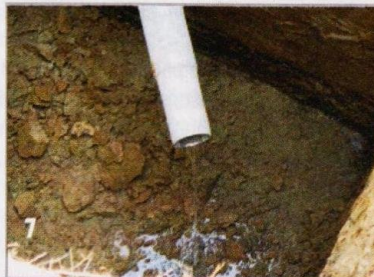
Проверка уклона труб.
