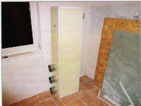
Готовые части магистрального воздуховода.
