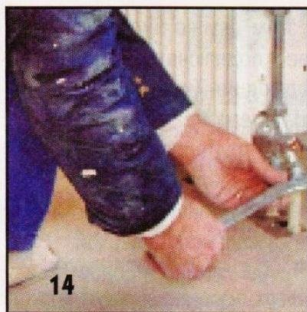
14 Подготовка элементов подключения труб: соединительные гайки следует затянуть покрепче.
