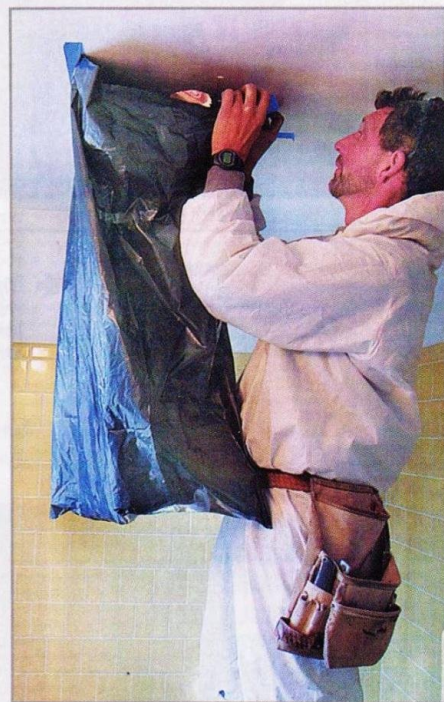
При вырезании проёмов в потолке вы не перемажетесь грязью, если воспользуетесь рабочим комбинезоном и пластиковым пакетом, прикреплённым клейкой лентой к потолку ванной.
