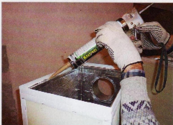
Нанесение герметика на Н-профиль перед соединением частей магистрального воздуховода.
