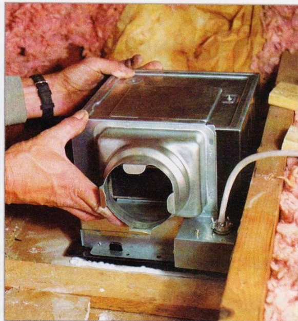
Установка вытяжного вентилятора.
