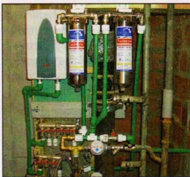
Выполнено полное подключение горячего и холодного водоснабжения, магистральных фильтров, счётчиков воды и нагревателя воды.
