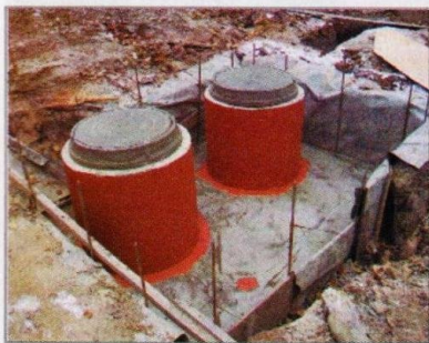
Спустя несколько дней после бетонирования перекрытия септик сверху гидроизолируют и засыпают грунтом. На кольца горловины устанавливают колодезные люки.
