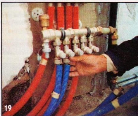
19 К распределительному устройству сначала подключают подающие (красного цвета), затем обратные (синего цвета) трубопроводы.
