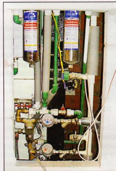
Шкаф-укрытие для стояка с подключёнными приборами закрывают декоративной стенкой с дверкой для удобства обслуживания.
