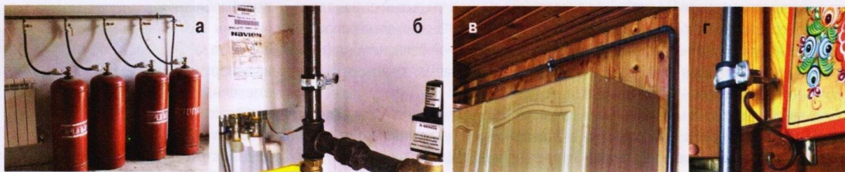
Фото 1. Прокладка газовых труб в помещении котельной (а, б) и в помещении кухни (в, г).
