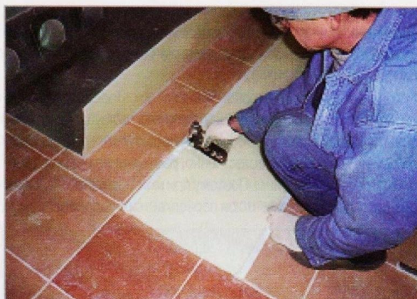
Крепление углового профиля скобами.
