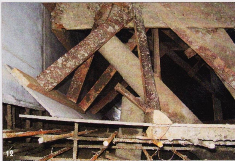
Опалубка септика. Скошенные углы — для укрепления конструкции.
