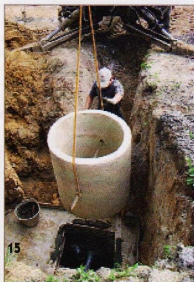
Монтаж колец над септиком.
