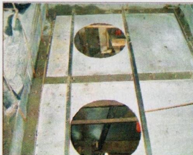
Опалубка перекрытия также выполнена из асбоцементных плит. В местах установки колец горловины в них заранее делают отверстия.
