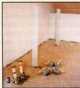
3 Из пола выступают только трубы и несущая шина. На трубы надевают элементы подключения.
