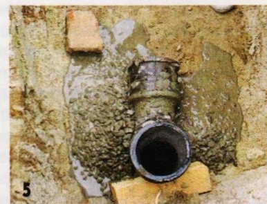
Установка колена для монтажа трубы стояка.
