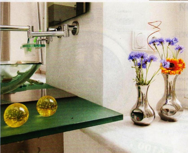
◀ Умывальник и столешница выполнены из декоративного триплекса – ударопрочного закаленного многослойного стекла толщиной 12 миллиметров
