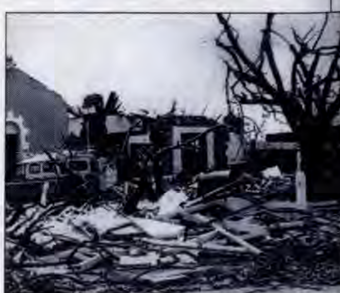
Разрушения, причиненные ураганом Трейси
