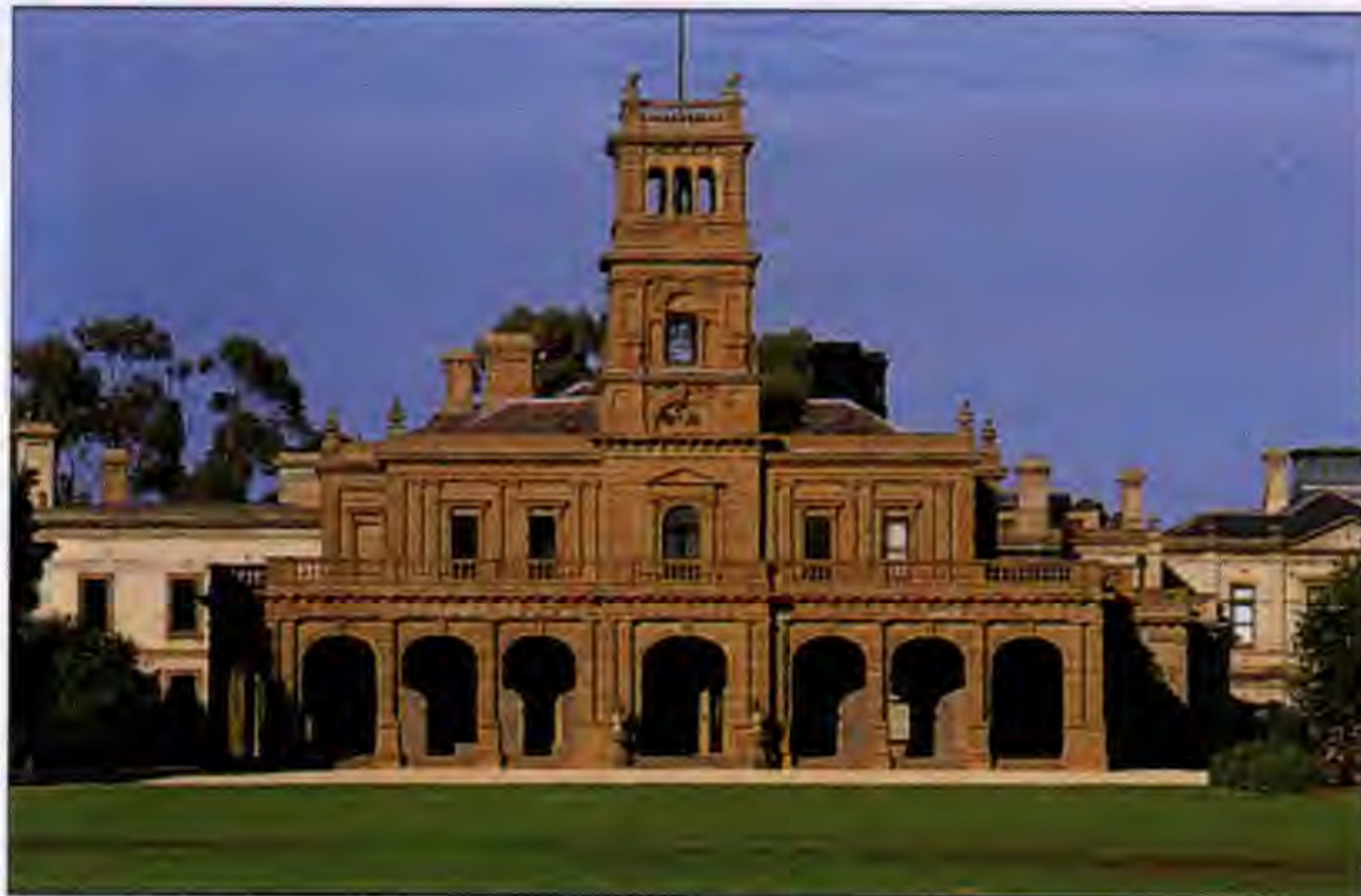
Изысканный в итальянском стиле фасад особняка в Уэрриби-парке
