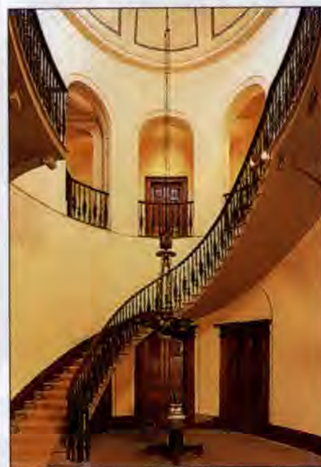
Консольная лестница под сводчатым потолком Элизабет-Бей хаус
