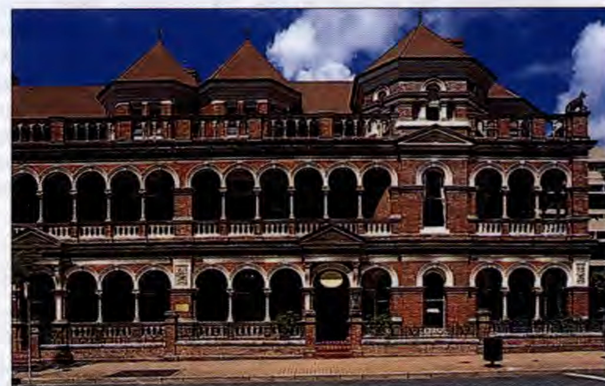
Особняки Район особняков — это ряд трехэтажных домов из красного кирпича с террасами, построенных в 1890-е годы. Арки из более светлого песчаника придают неповторимое своеобразие этому проекту.
