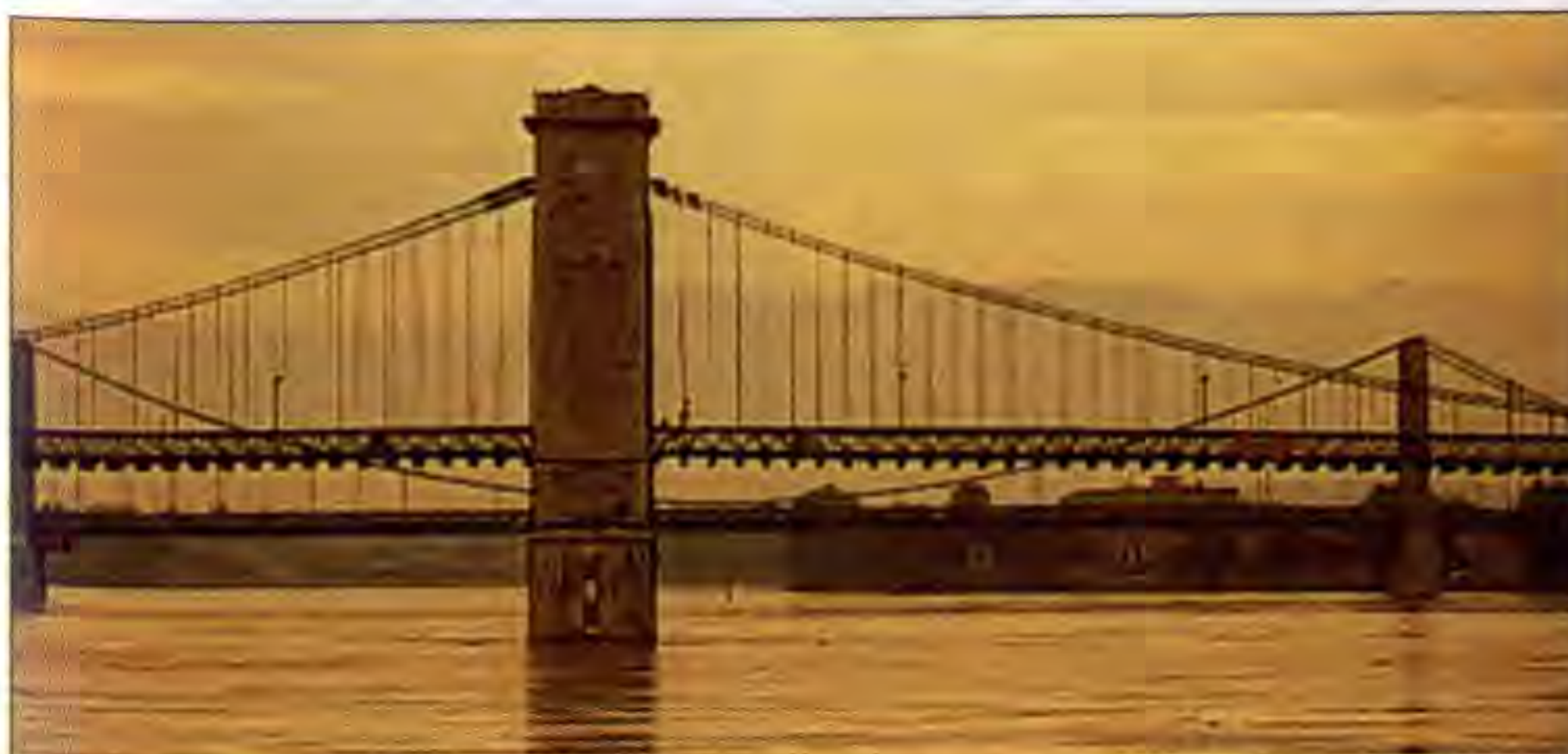
Подвесной мост через реку Рона близ Турнон-сюр-Рон
