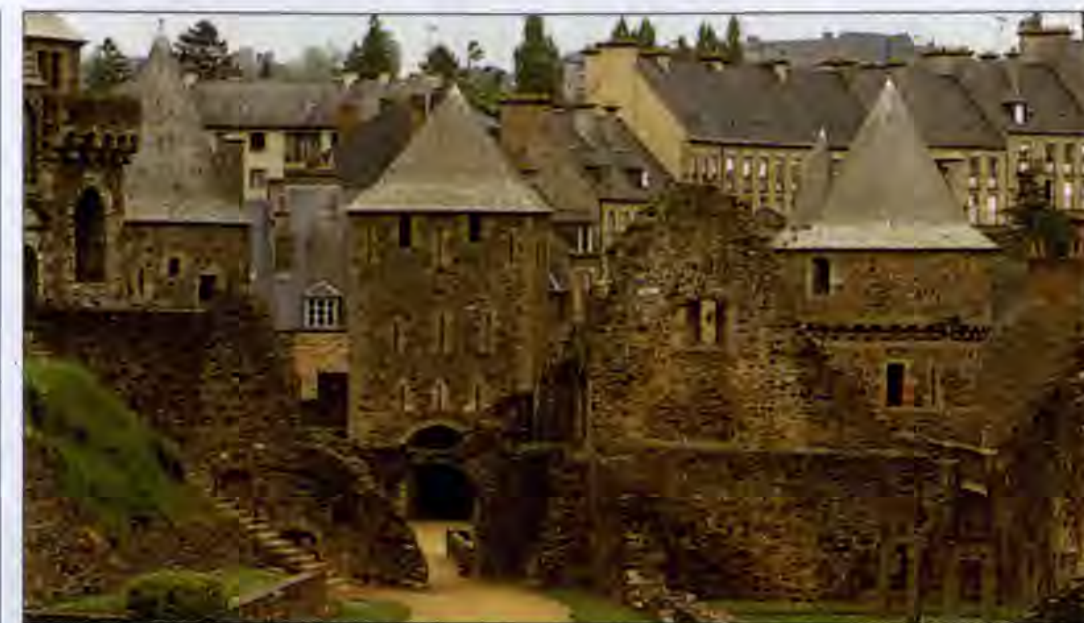
Впечатляющие сооружения замка де Фужер
