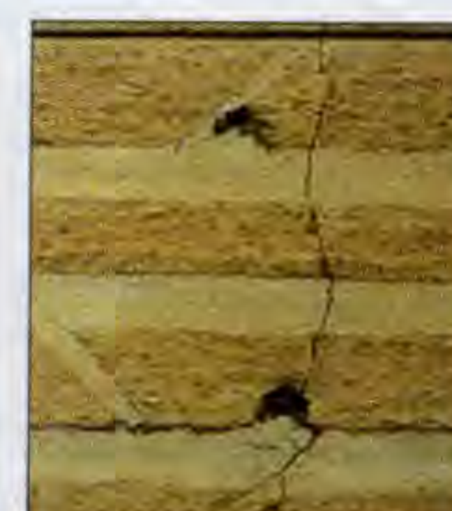
Глинобитная стена (смесь глины, гравия и соломы)
