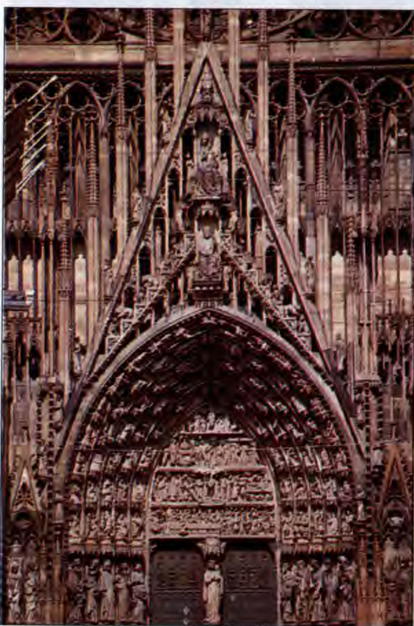
Центральный портал западного фасада
