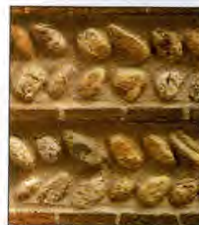
Стена, сложенная из булыжников и кирпича
