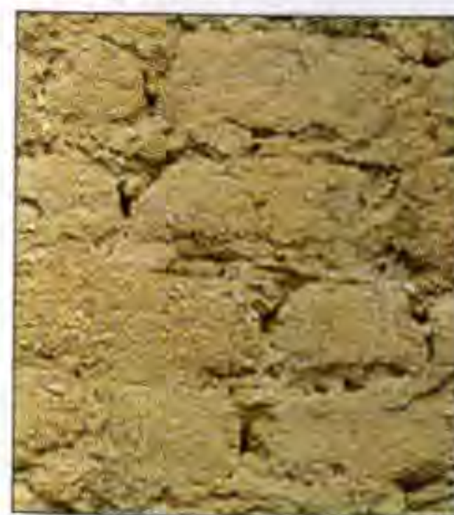
Саманная стена (из необожженного кирпича)
