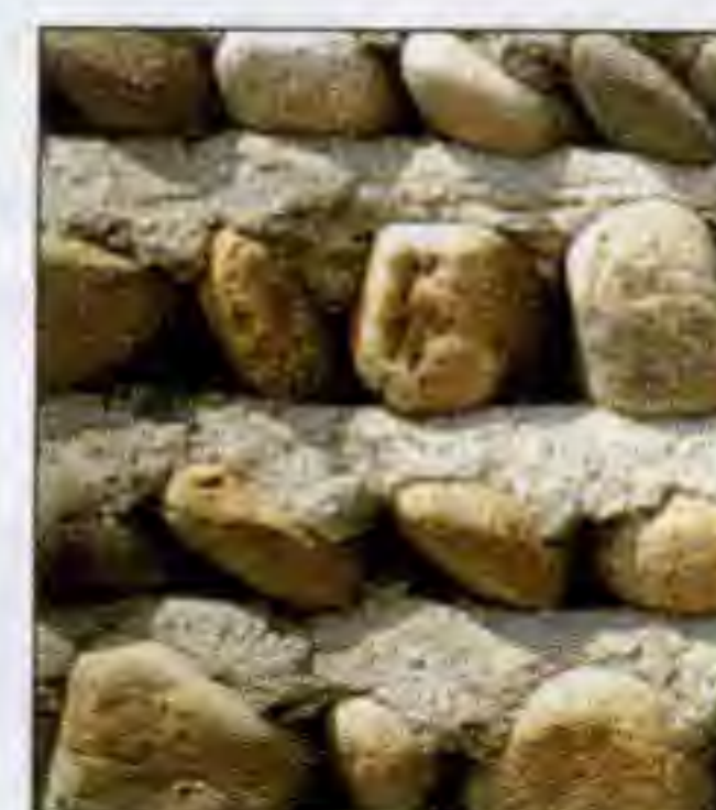
Камни, скрепленные строительным раствором
