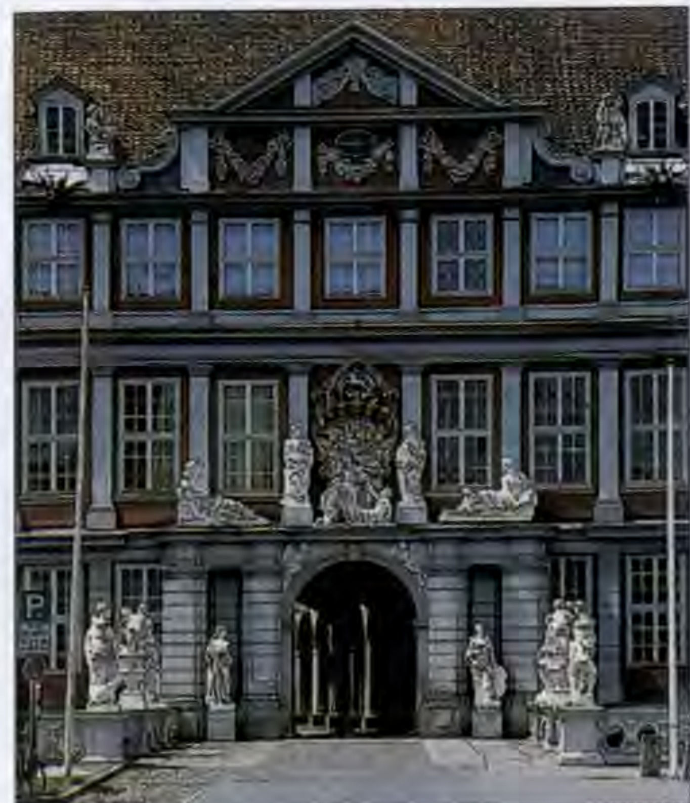
Барочный фасад замка Вольфенбюттель
