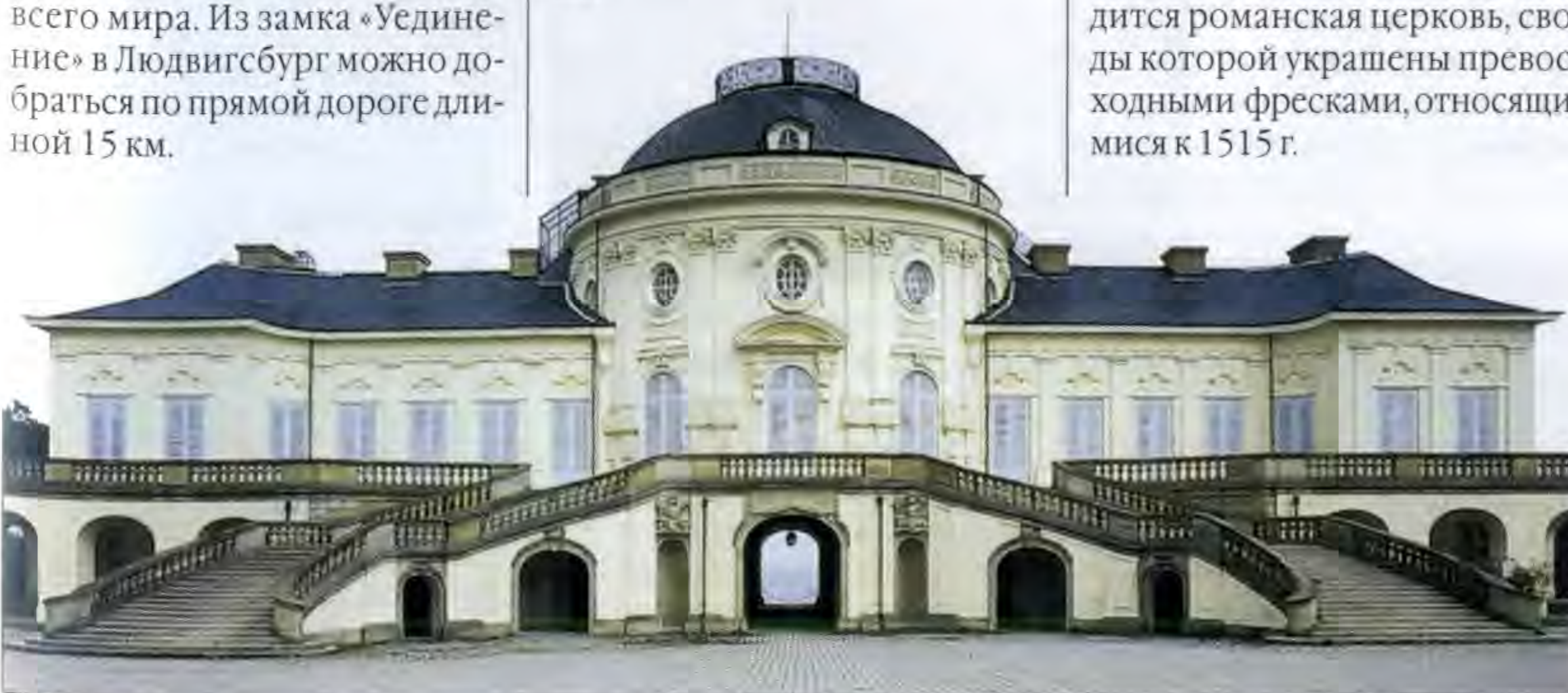
Фасад замка «Уединение», расположенного на холмах к западу от центра Штутгарта
