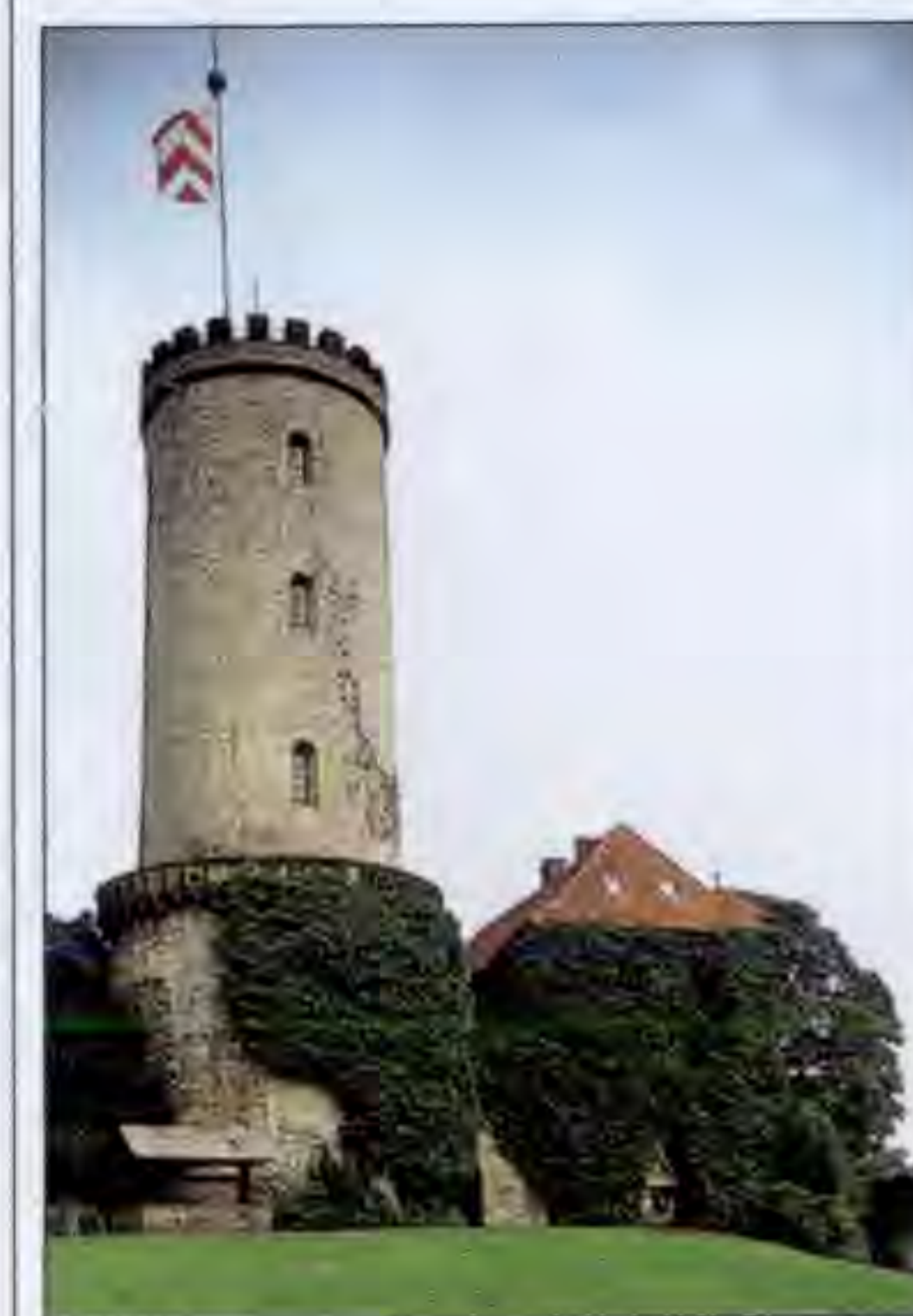
Наблюдательная башня в комплексе Шпарренбург. Билефельд
