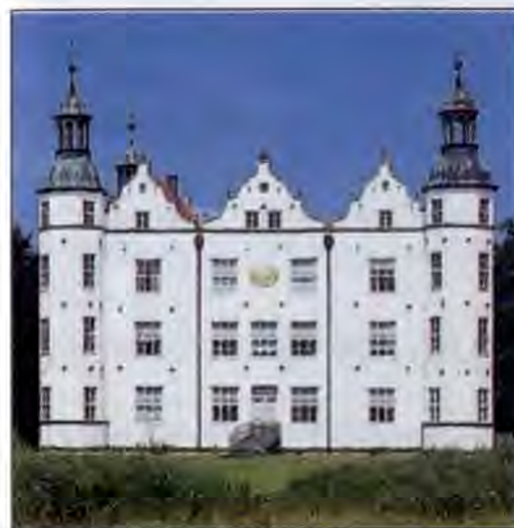
Фасад замка Арнебург с боковыми башнями
