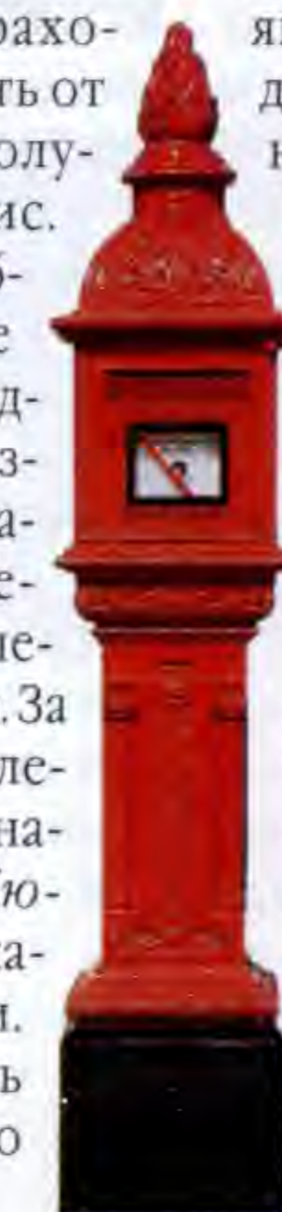
Кнопка экстренного вызова пожарной бригады
