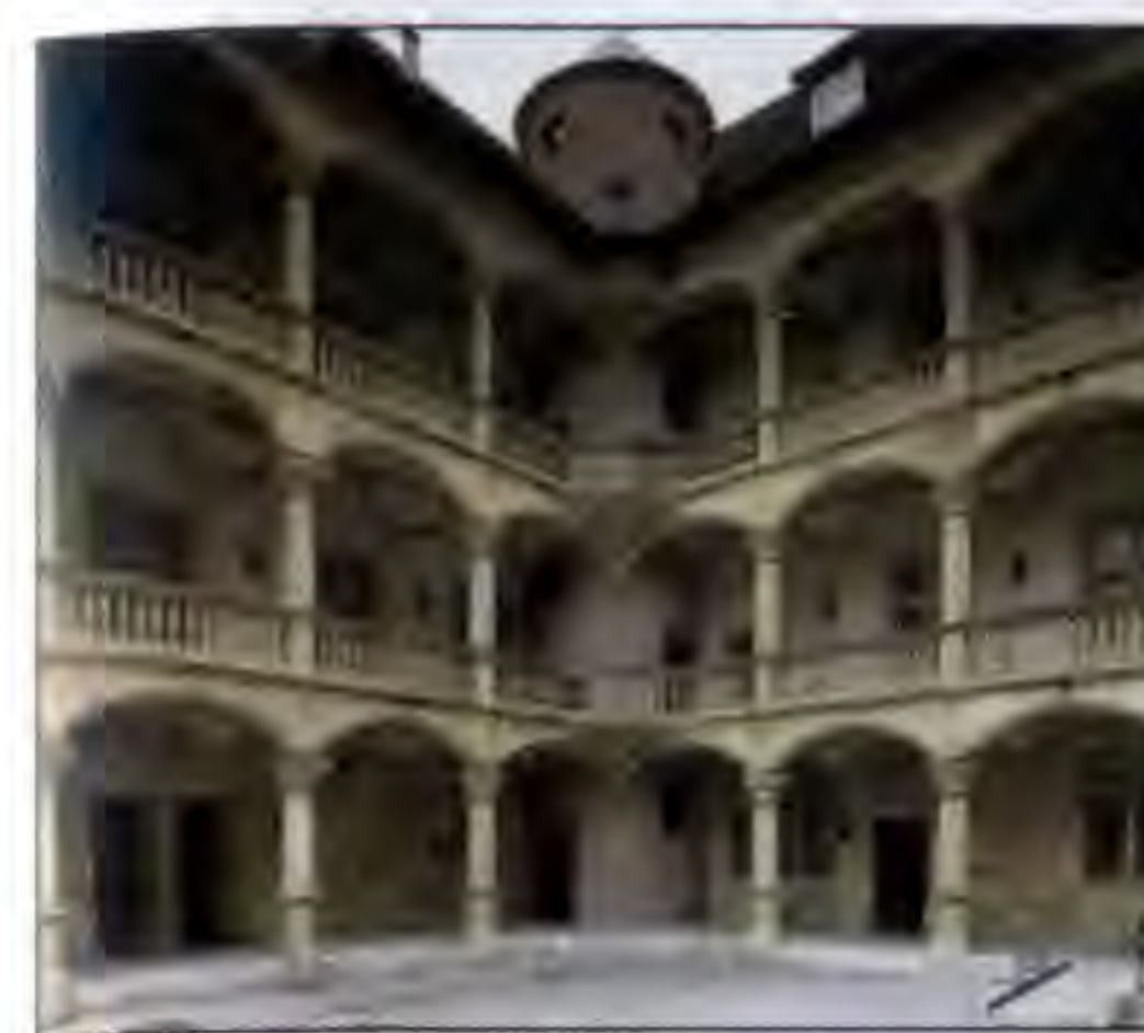
Внутренний двор Старого замка с галереями эпохи Возрождения
