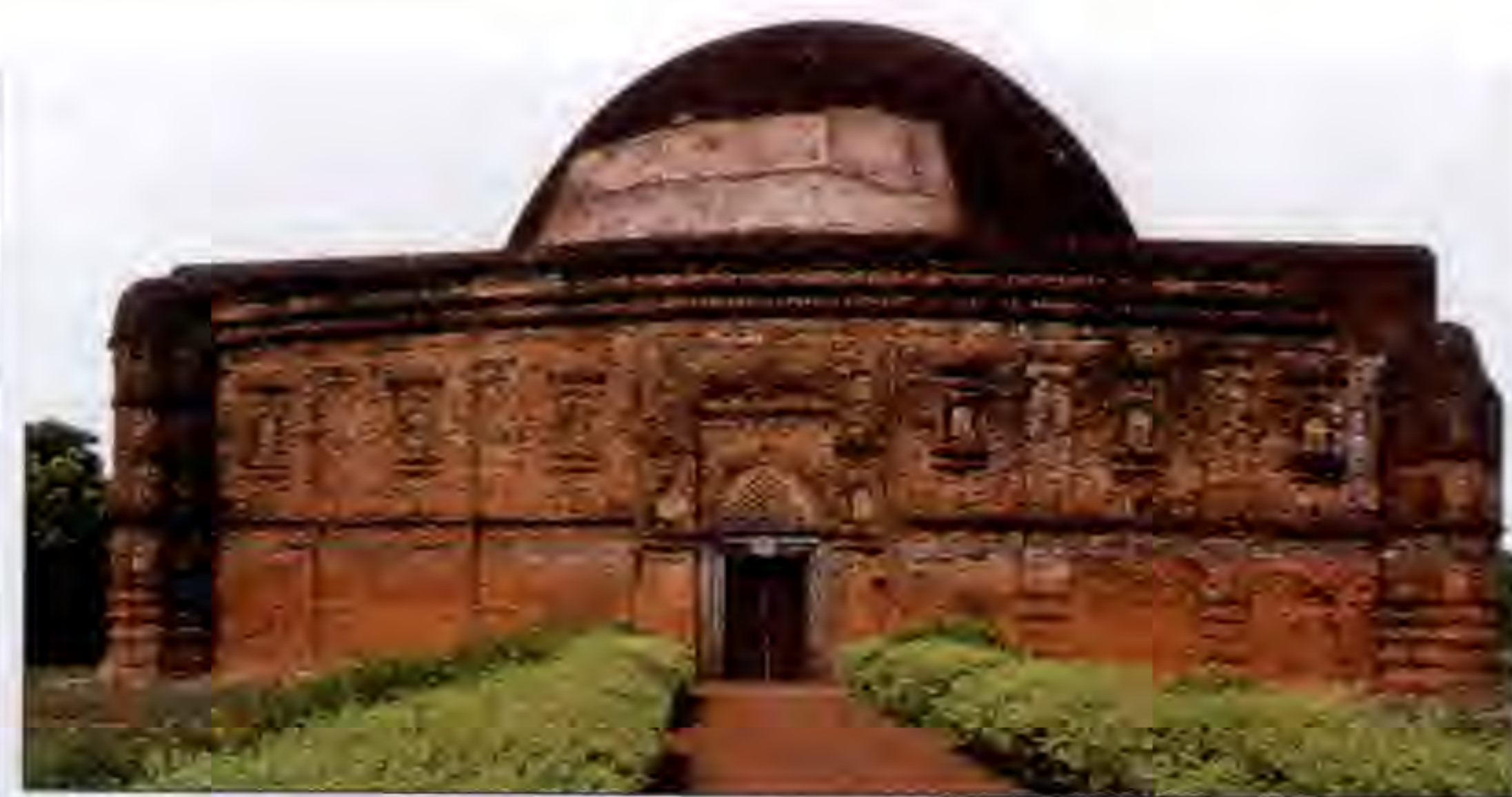
Резной терракотовый фасад мавзолея Эклакхи в Пандуа
