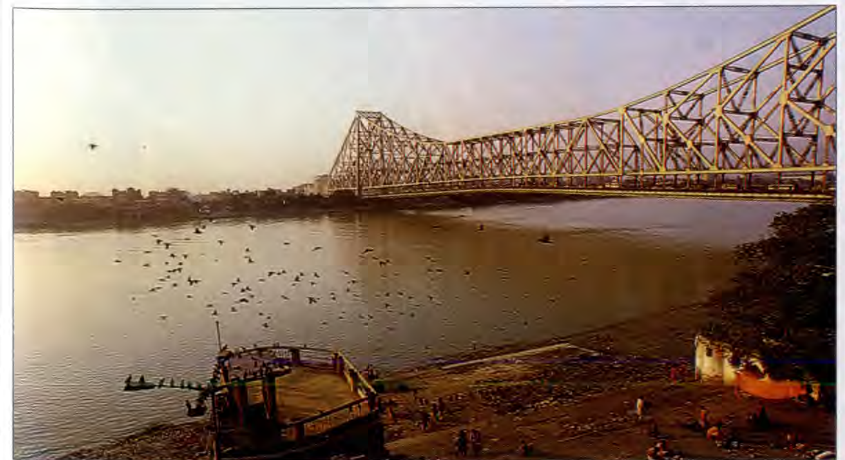
Вид реки Хугли и моста Ховрах (третьего по протяженности консольного моста в мире)
