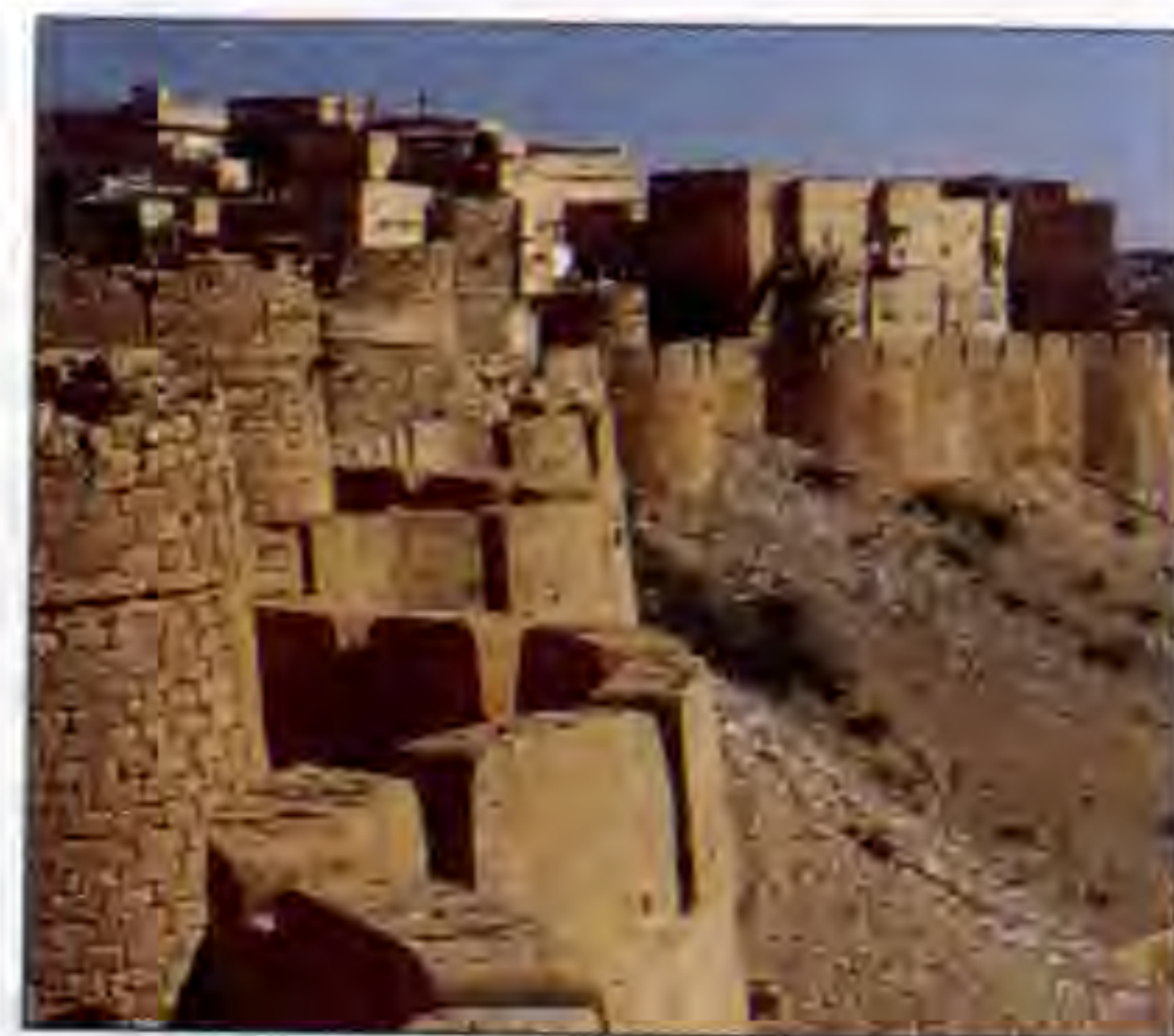
Южные стены строились из камня без применения связующего раствора.
