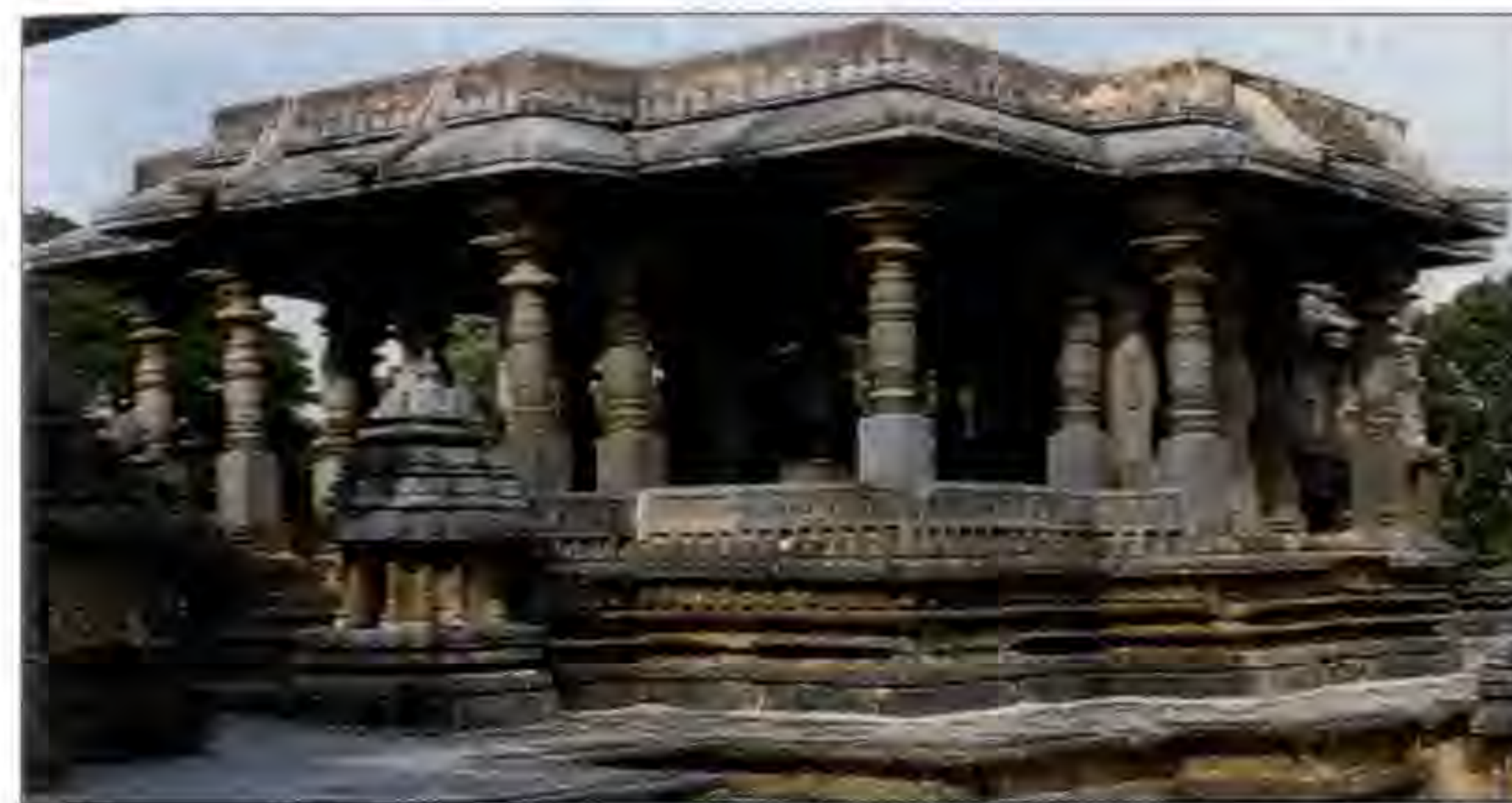
Павильон Нанди с колоннадой в храме Хойсалешвара в Халебиде
